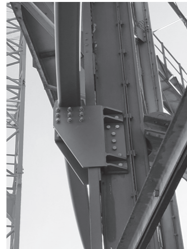
Die Stahllasten an den Gerüststielen und der Ringträger sind montiert
