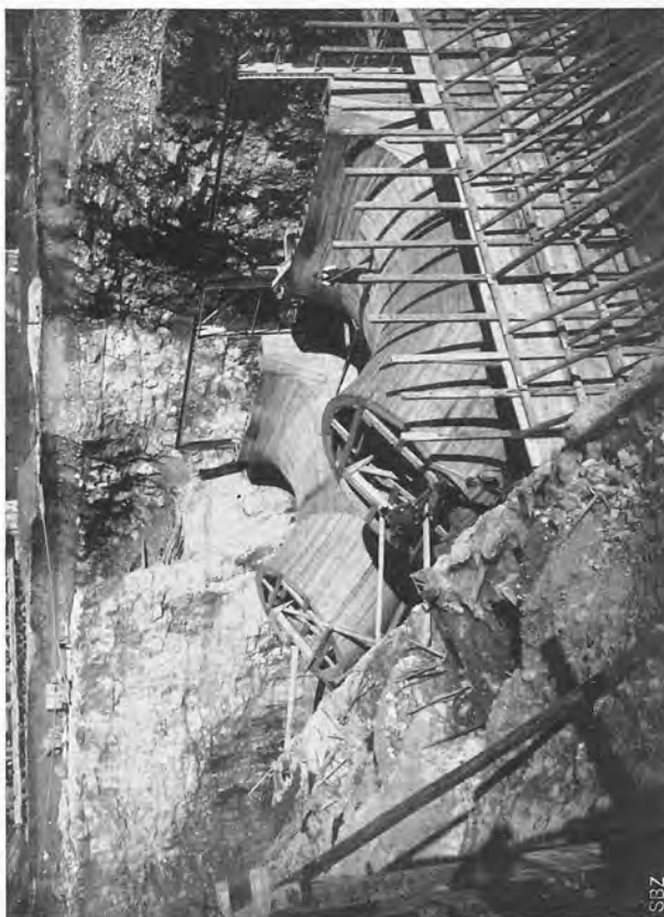
Abb. 88. Verschaltungen für die Saugkrümmer der linksseitigen Turbinen 1 und 2 mit den Führungen für die Dammbalken-Abschlüsse. — 28. I. 1916.
