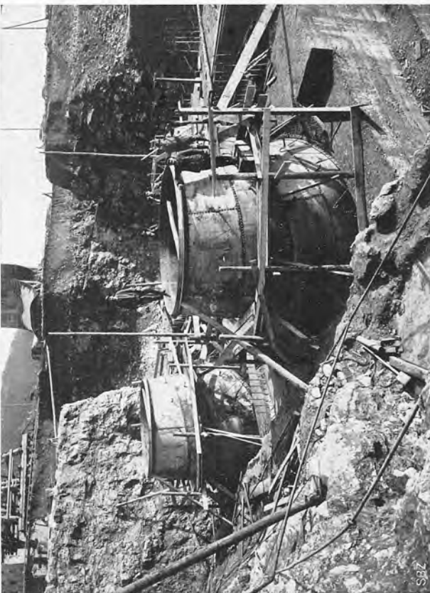
Abb. 91. Panzerungen am obern Ende der Saugkrümmers der linksseitigen Turbinen 1 und 2 (Teilaussicht zu Abb. 89), 10. III. 1916.
