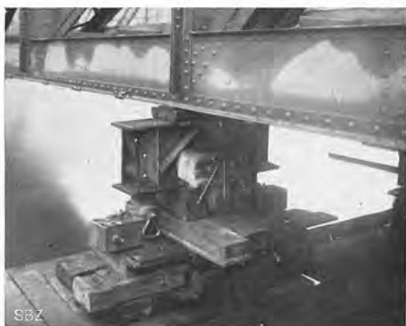
Abb. 7. Hebung der Rankwaag-Brücke mittels hydraulischer Winden.
