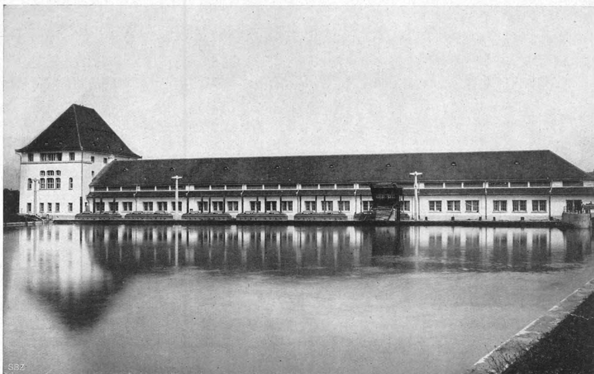
Abb. 74. Das Maschinenhaus des Kraftwerks Gösgen von der Oberwasserseite.
