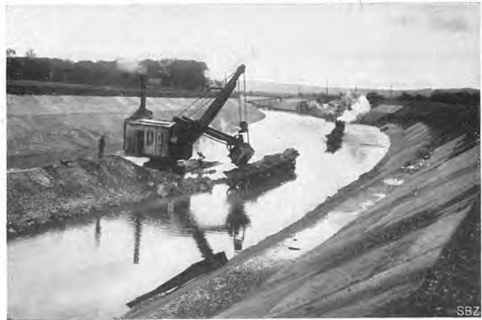
Abb. 48. Kanalpartie bei Km. 9 bis 10 im Bau. An der Böschung rechts Betonverkleidung unvollendet (26. XI. 15).
