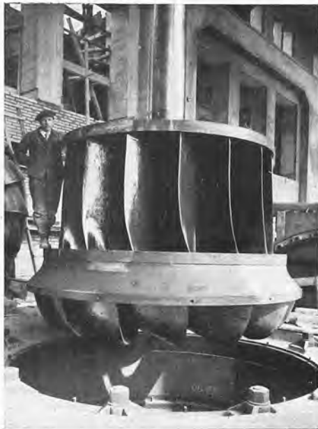
Abb. 111. Laufrad der Turbine.
