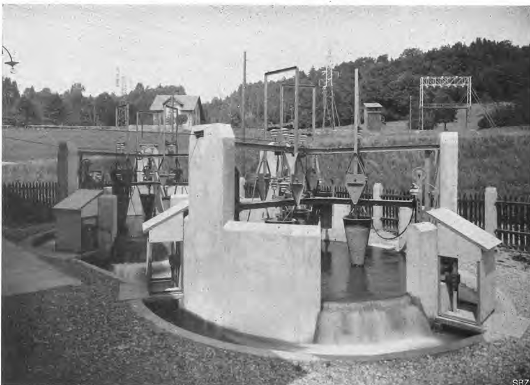
Abb. 126. Belastungswiderstände für je 12000 kW bei 8000 V.
