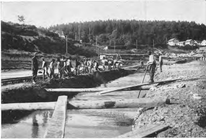
Abb. 53. Einschwemmen des Lehms für den Sporn des rechtsseitigen Damms bei Km. 3 (vergl. Abb. 51).
