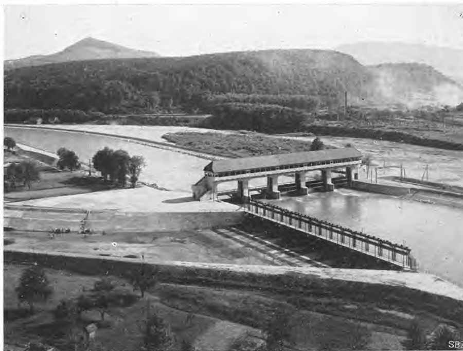
Abb. 6. Stauwehr und Kanaleinlauf (Kanal leer). — Aufnahme vom 13. Juni 1917.
