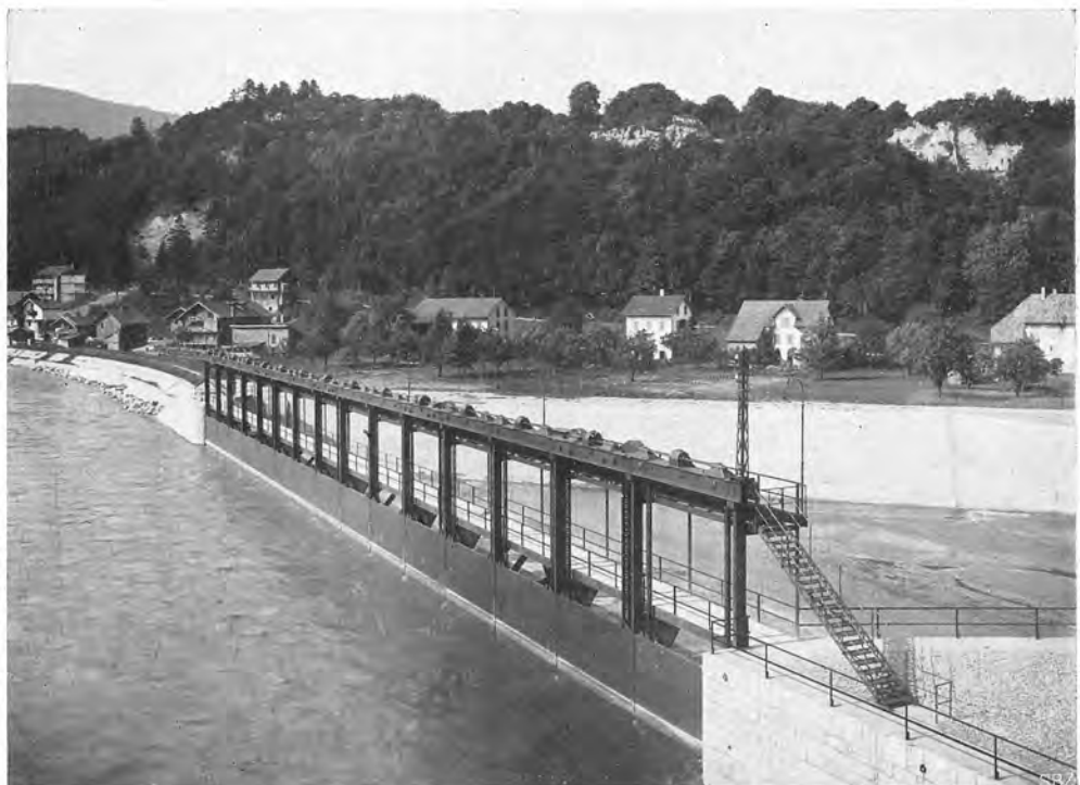
Abb. 45. Einlauf-Bauwerk des Oberwasser-Kanals des Kraftwerks Gösgen.
