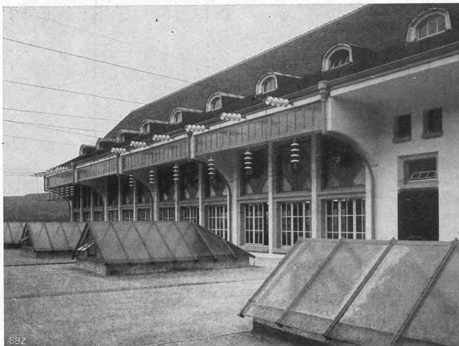
Abb. 138. Ausführung der abgehenden Leitungen für 50000/70000 V.
