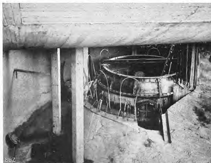
Abb. 96. Inneres einer Turbinenkammer mit provisorischen Säulen für die Abstützung des Maschinenhaus-Bodens. Rechts der Turbinen-Untersatz mit Zugang zum Saugrohr. 27. X. 1916.
