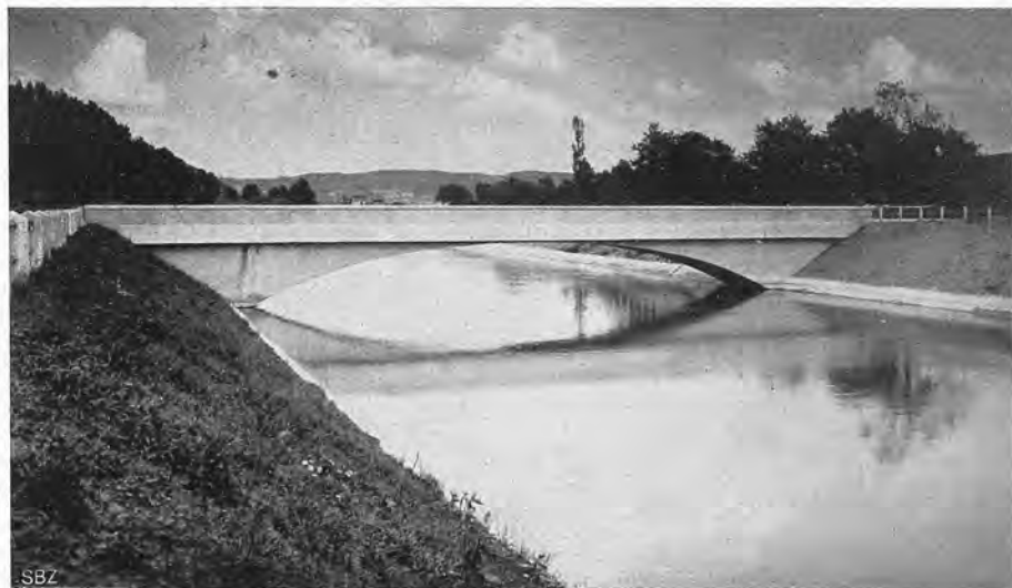
Abb. 70. Strassenbrücke über den Oberwasserkanal bei Km. 4,08 mit auskragendem Betonkanal für die Ueberleitung des Mühlebaches.
