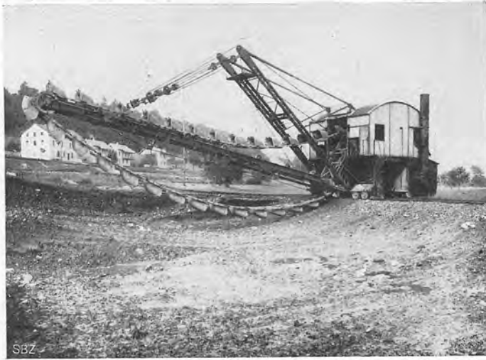
Abb. 104. Beginn der Baggerung für die Maschinenhaus-Baugrube. Aufnahme vom 31. VII. 1914.
