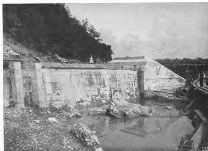
Abb. 68. Unterer Teil des Stegbach-Durchlasses bei Km. 3,285 mit Rippen für den Lehmkern, vor der Dammanschüttung.
