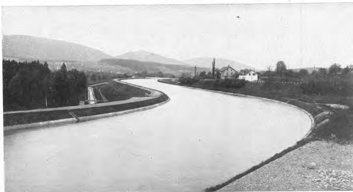
Abb. 57. Dammstrecke des Kanals von Km. 3,2 aufwärts gesehen. Die Dammkronen liegt 12 bis 13 m über der Sohle des Parallelgrabens. (Aufnahme vom 23. V. 1918.)
