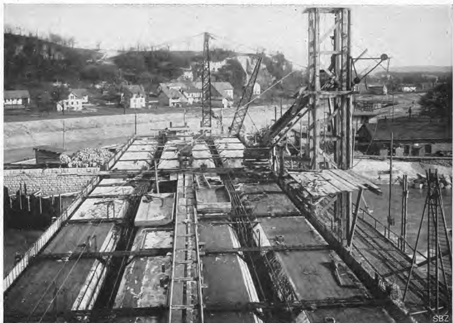
Abb. 26. Verschalungsgerüst für die Tafel des Dienststeges über Oeffnung 2 und 3. (15. XI. 1915.)
