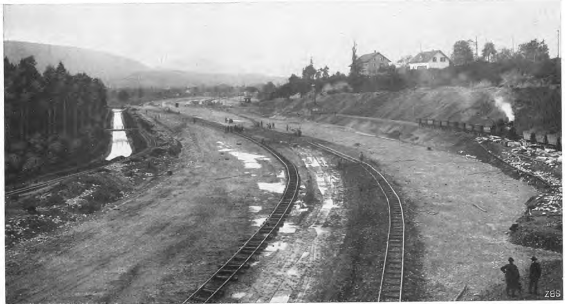
Abb. 56. Damm bei Km. 3,2 kanalaufwärts gesehen. Zwischen den Geleisen der bis auf Kanalsohlenhöhe ausgeführte Lehmkern (14. X. 15).
