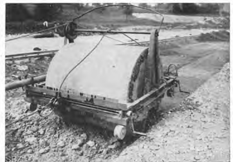
Abb. 54. Einrollige Walze mit Seilbetrieb für das Walzen des Lehm-kerns.
