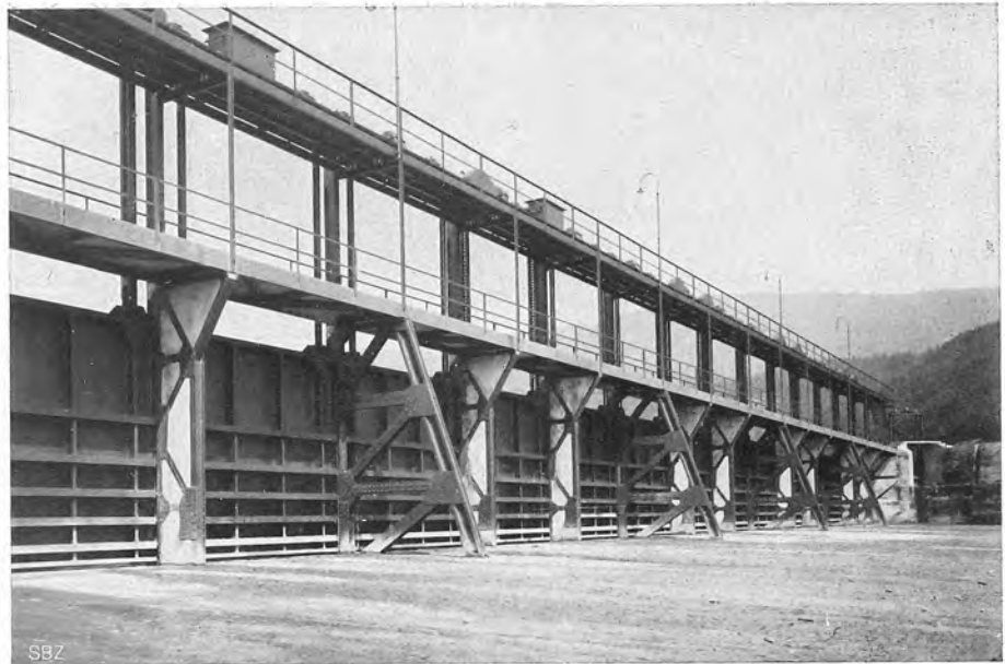
Abb. 44. Einlauf-Bauwerk des Oberwasser-Kanals, vom leeren Kanal aus gesehen.
