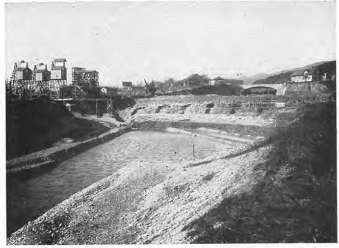
Abb. 105. Blick vom Unterwasserkanal gegen die Maschinenhaus-Baustelle. Links die rechtsseitigen Türme der Kabelbahn-Anlage. 13. XI. 1915.
