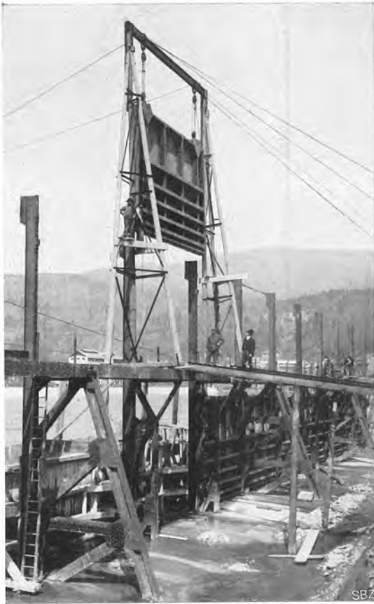
Abb. 43. Einsetzen der Schützentafeln am Kanal-Einlauf. Schütze in höchster Stellung (27. April 1916).
