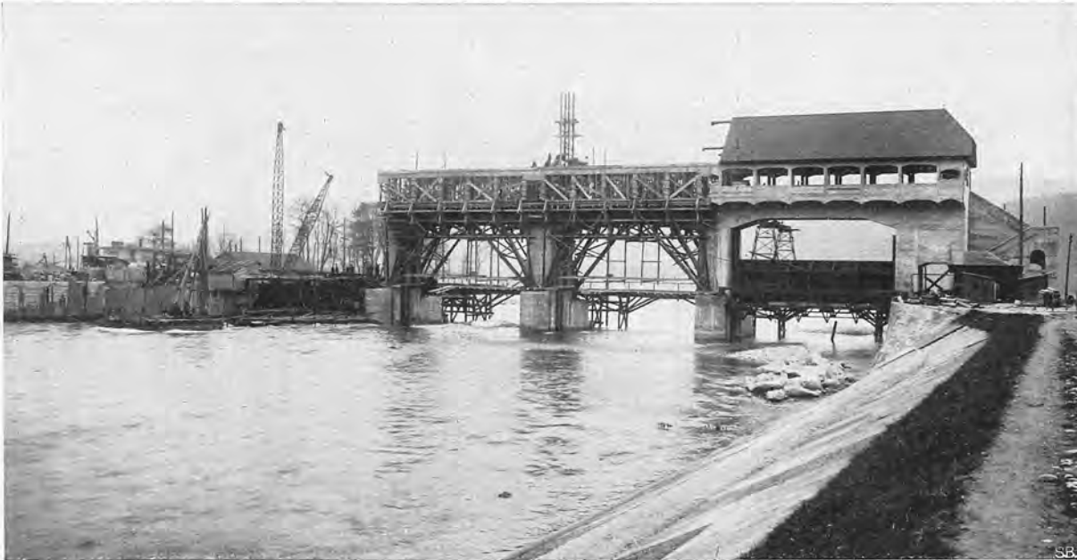
Abb. 27. Bau des Dienststeges: über Oeffnung 1 vollendet, in Oeffnung 2 und 3 Verschalungsgerüst. (16. XII. 1915.)
