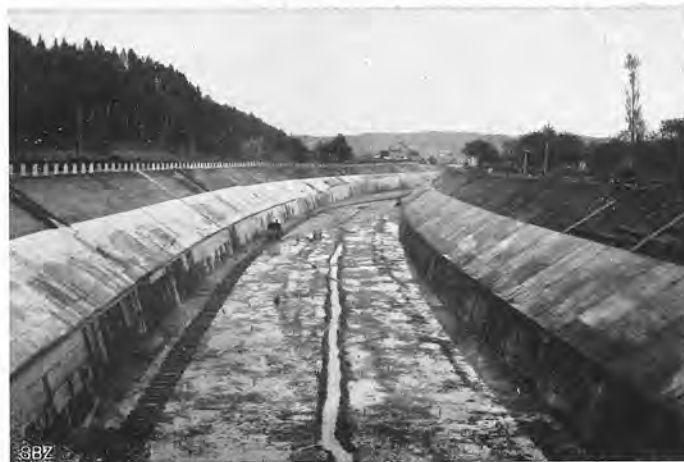
Abb. 59. Fertiges Kanalprofil in der Felspartie bei Km. 4,3.
