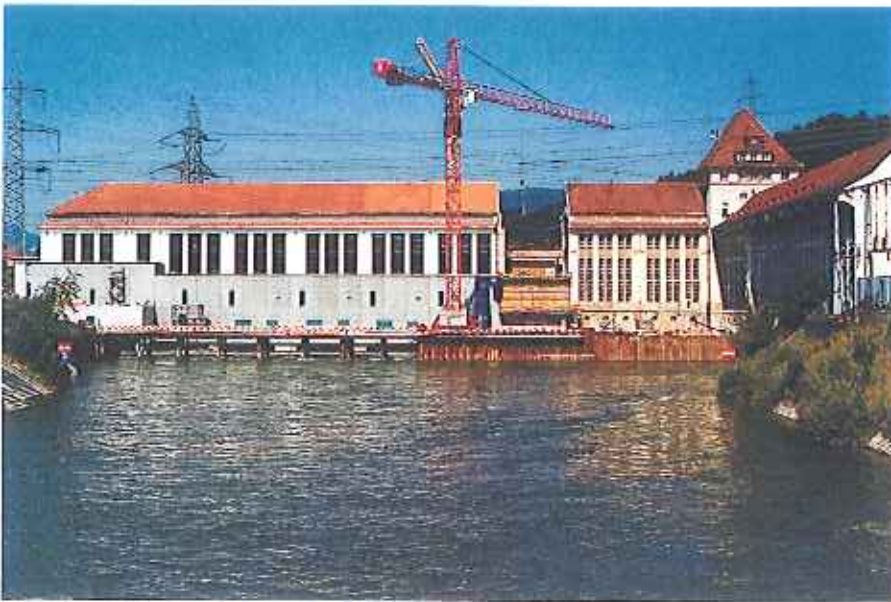
Bild B2-3. Blick auf die Unterwasserseite des Wasserkraftwerkes Gösgen während der 5. Bauetappe im Juli 2000. Das neu erstellte Maschinenhaus mit anschliessendem Vorbau zeigt deutlich die neuzeitlichen Nuancen der Architektur auf, im Gegensatz zu dem alten Gebäudeteil im Stile des Klassizismus auf der rechten Seite, welches aus Gründen des Denkmalschutzes erhalten wurde.
