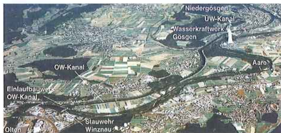
Bild B1-2. Luftaufnahme der gesamten Stauanlage Gösgen mit dem Wehr Winznau, dem Einlaufbauwerk, dem Oberwasserkanal, dem Wasserkraftwerk Gösgen und dem Unterwasserkanal.
