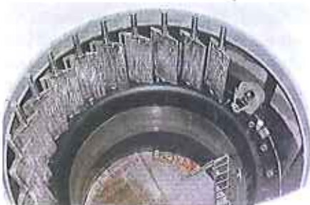
Bild B7-2. Montage der Leitschaufeln.
