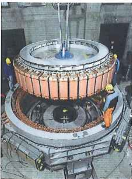
Bild B7-3. Einfahren Generatorrotor in Stator (Foto Siemens).
