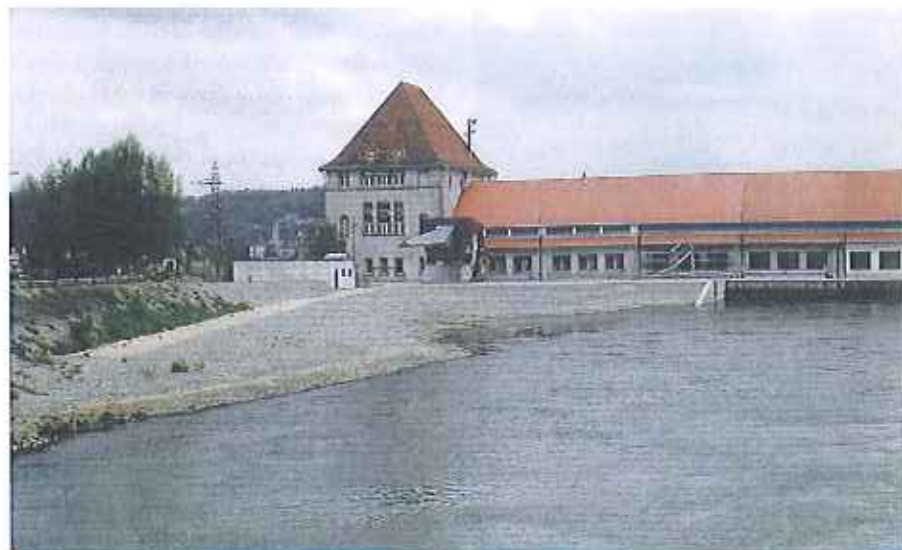
Bild B6-12. Gestaltung der linken Oberwasserschüttung nach Fertigstellung der Arbeiten. Die effektive Leitwand liegt unter dem Wasserspiegel und ist daher nicht ersichtlich.
