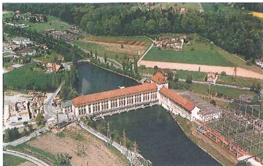
Bild B1-1. Aufnahme des Wasserkraftwerkes Gösgen vor der Erneuerung.
