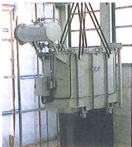
Bild B8-1. Einbringen eines Maschinentransformators in die Transformatorzelle mit Hilfe des Maschinensaalkranes.
