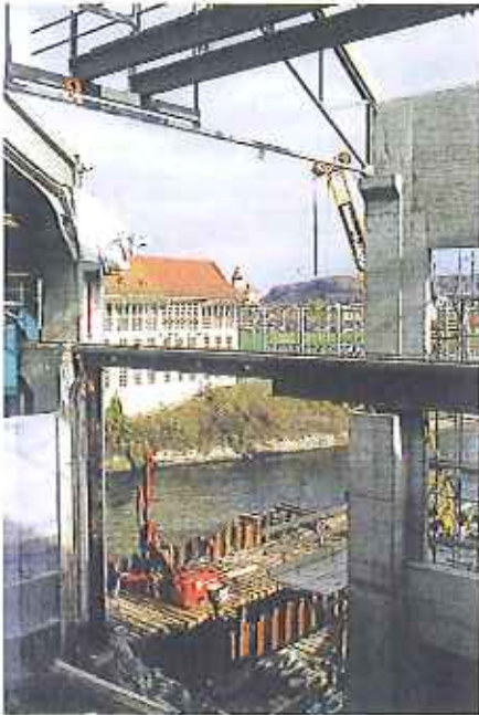
Bild B6-10. Montage der provisorischen Kranbahn.
