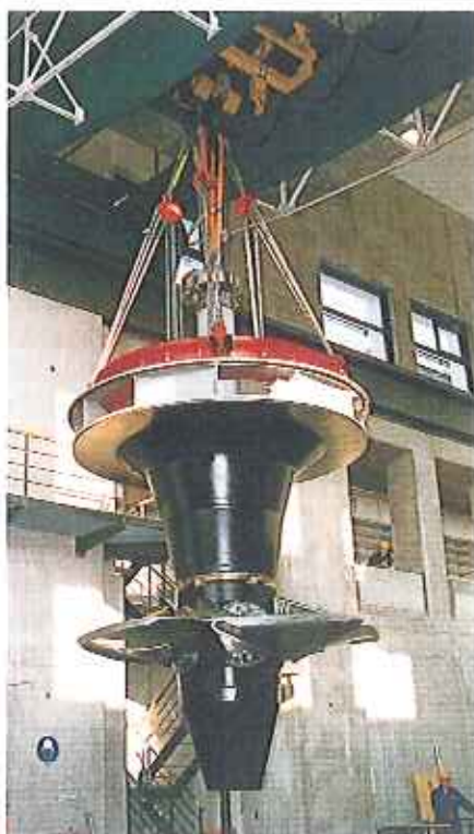
Bild B7-1. Einfahren und Montage der Turbine Gruppe 3. Die mit dem Maschinensaalkran versetzte Turbine mit einem Laufraddurchmesser von 3,60 m und fünf Schaufeln ist mit dem Turbinendeckel und der Turbinenwelle 34 Tonnen schwer.
