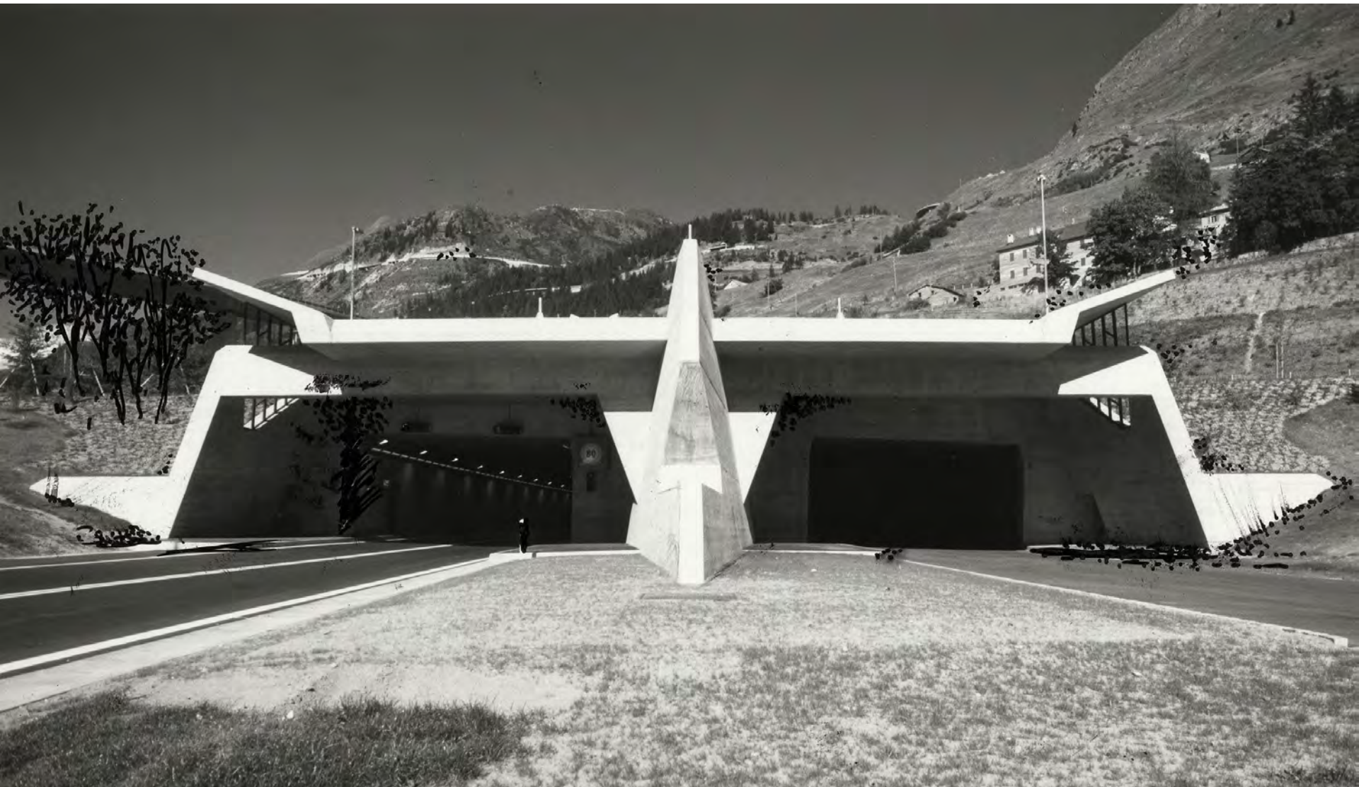
Arch. Rino Tami, portale della galleria del San Gottardo ad Airolo
