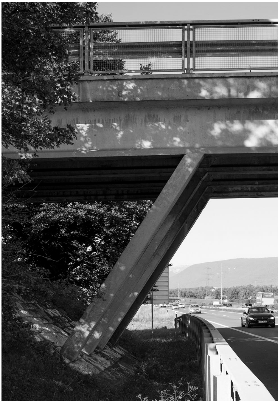
Passage supérieur sur l'autoroute Genève - Lausanne: vue de la culée. © Yves André
