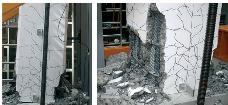
Fig. 10 Encastrement colonne P0 avec flambage des barres. Confined section of column P0 with buckling of steel bars.
