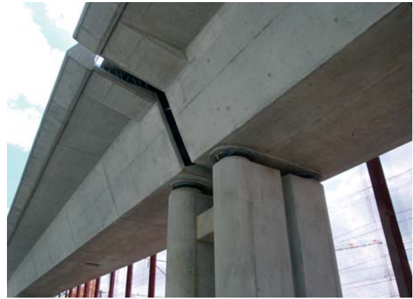
Fig. 6 Abschnittsgrenze. Expansion joint.
