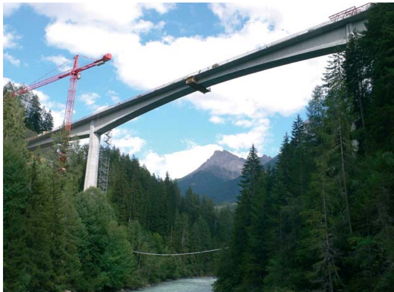
Fig. 6 Fugenschluss im Mittelfeld. Closure pour at midspan.
