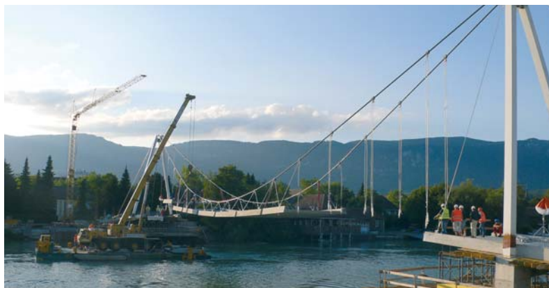
Fig. 7 Bau der Flussspannweite. Construction of the central span.
