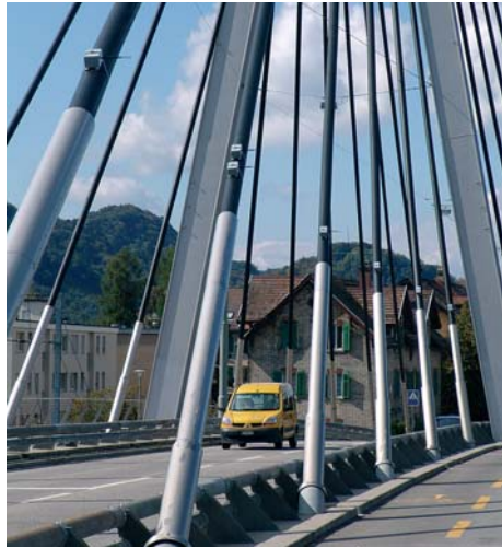
Fig. 1a Schrägseile der Storkenbrücke mit Sensor-knoten. Cable stays of the Stork Bridge with sensor nodes.
