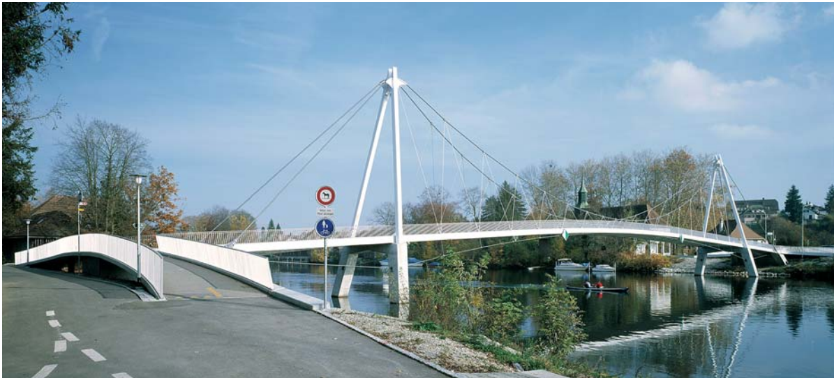
Fig. 8 Aaresteg: Ansicht von der Oberwasserseite. Aare footbridge: view from upstream.
