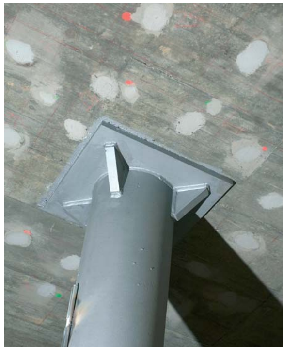
Fig. 8 Face inférieure de la dalle après installation des armatures et de la protection anti-feu. Soffit of the slab after installation of the shear reinforcement and the fire protection.
