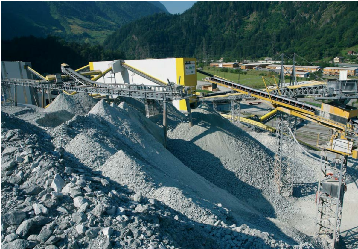
Fig. 4 Zwischenlager mit ausgebrochenem Material. Interim storage of excavated material.
