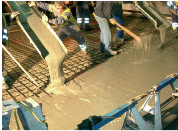
Fig. 4 Giessen des UHFB auf die Hochbaudecke. Casting the UHPFRC on the slab of the building.
