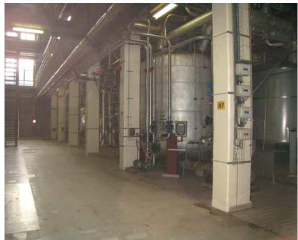
Fig. 2 Colonnes du rez-de-chaussée. Ground floor columns.
