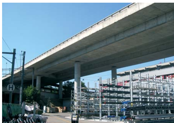
Fig. 1 Weyermannshaus-Viadukt, Bern. Weyermannshaus Viadukt, Berne.
