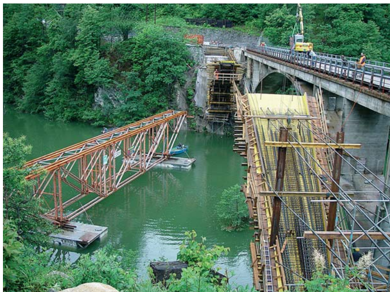
Fig. 4 Fase di montaggio della centina. Erection phase for the falsework.
