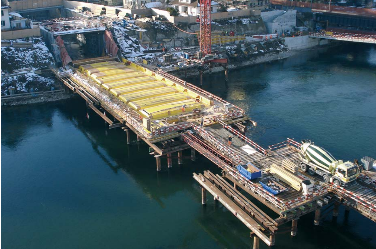
Fig. 1 Stand der Arbeiten im Februar 2010. Der Tagbautunnel ist im Rohbau erstellt. In Bildmitte ist die Schalung für die erste Überbauetappe sichtbar. The state of construction in February 2010, with the completed tunnel and, in the middle of the picture, the formwork for the first stage of the cover slab.
