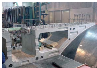
Fig. 3 Réalisation d'un voussoir préfabriqué en usine. Prefabrication of a segment in the plant.
