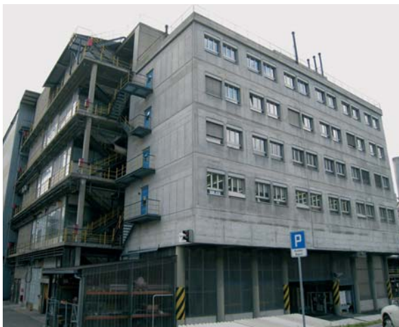
Fig. 1 Bâtiment Niazol D29. Niazol D29 building.
