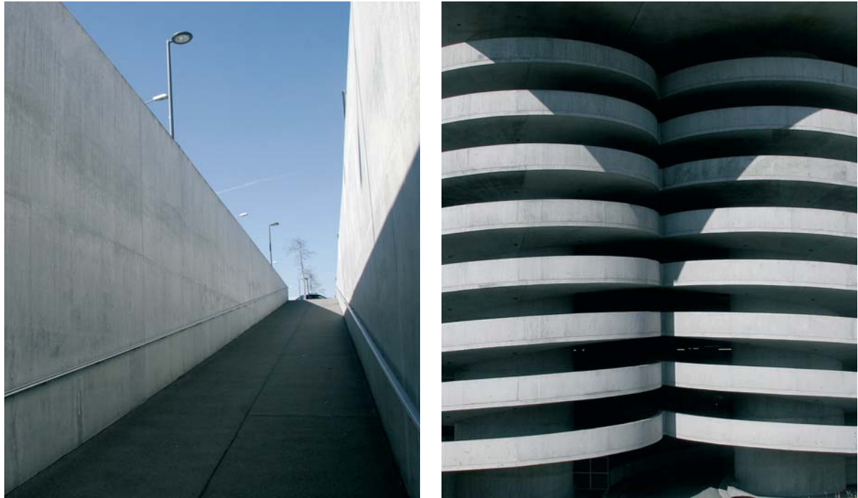
Fig. 2 Beton ist ein wesentlicher Teil unserer gebauten Umwelt. Concrete forms an important part of our built environment.
