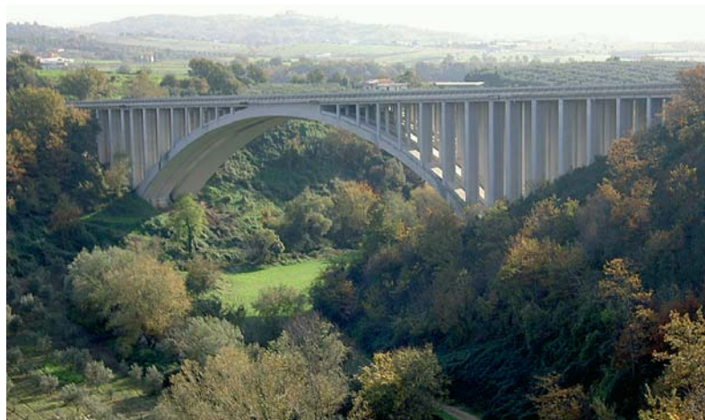
Fig. 1 Vista del ponte Tenza. Tenza bridge view.
