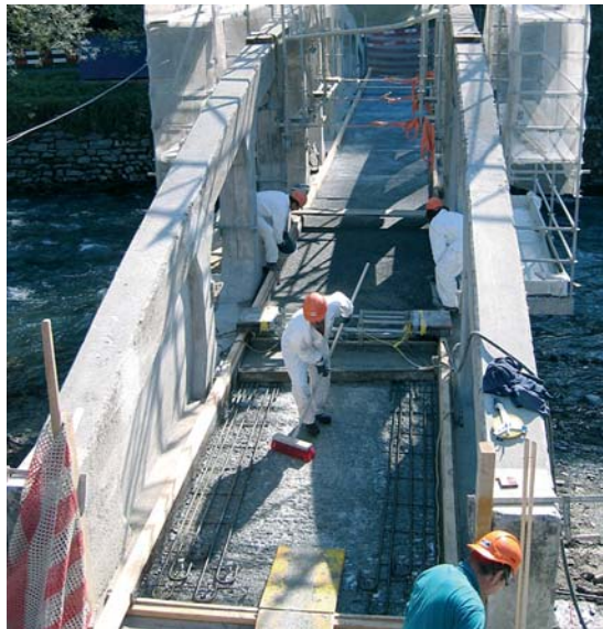
Fig. 5 Einbau des UHFB auf die Fahrbahnplatte. Placing of the UHPFRC on the bridge deck slab.
