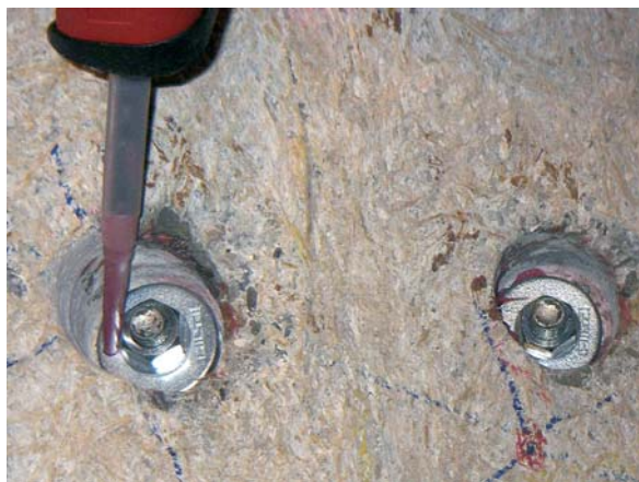
Fig. 7 Installation des têtes d'ancrage inférieures. Installation of the lower anchorage heads.
