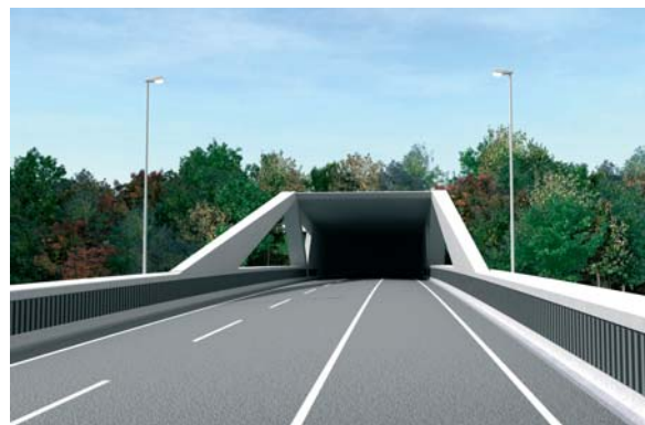
Fig. 3 Blick über die Brücke Richtung Hausmatt-Tunnel. View over the bridge in the direction of the Hausmatt Tunnel.
