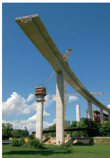
Fig. 6 Vue du viaduc Nord après clavage 4-5. View of North viaduct after connection 4-5.
