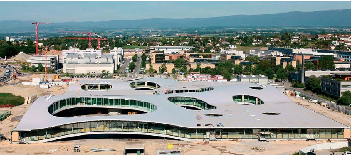
Fig. 2 Fertiggestellter Rohbau mit Patios. Completed structure with large patios.
