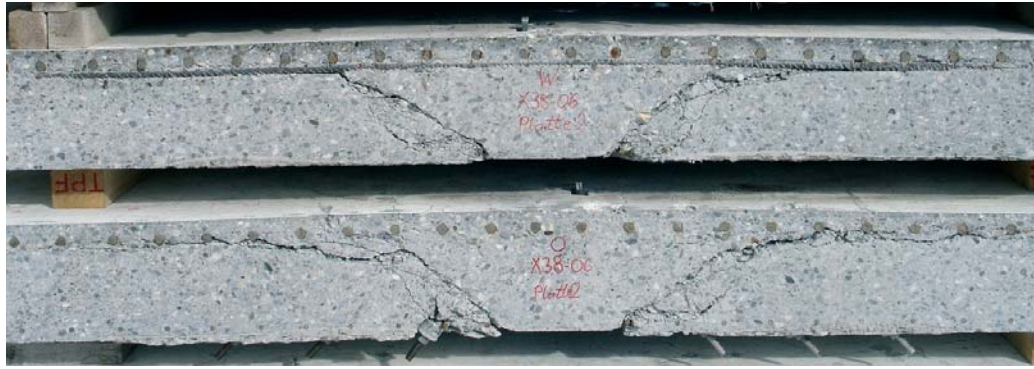
Fig. 4 Dalle avec armature de poinçonnement coupée après l'essai. Slab with post-installed shear reinforcement cut open after test.
