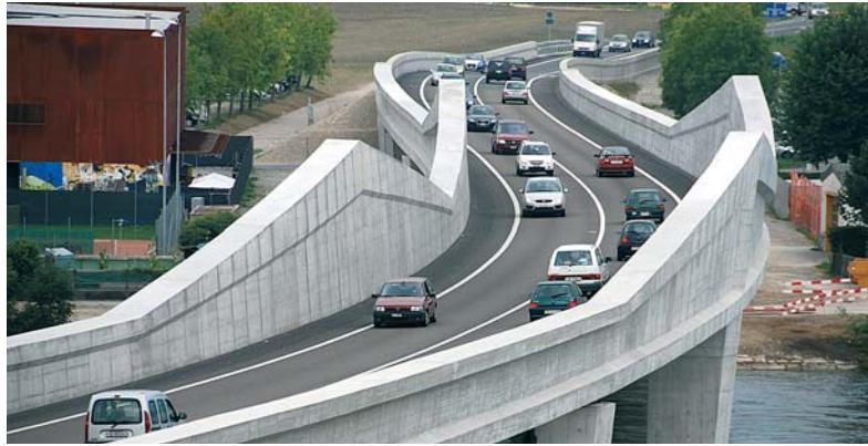
Fig. 2 Brückenüberbau mit integriertem Lärmschirm. Bridge girder with integrated noise protection barrier.
