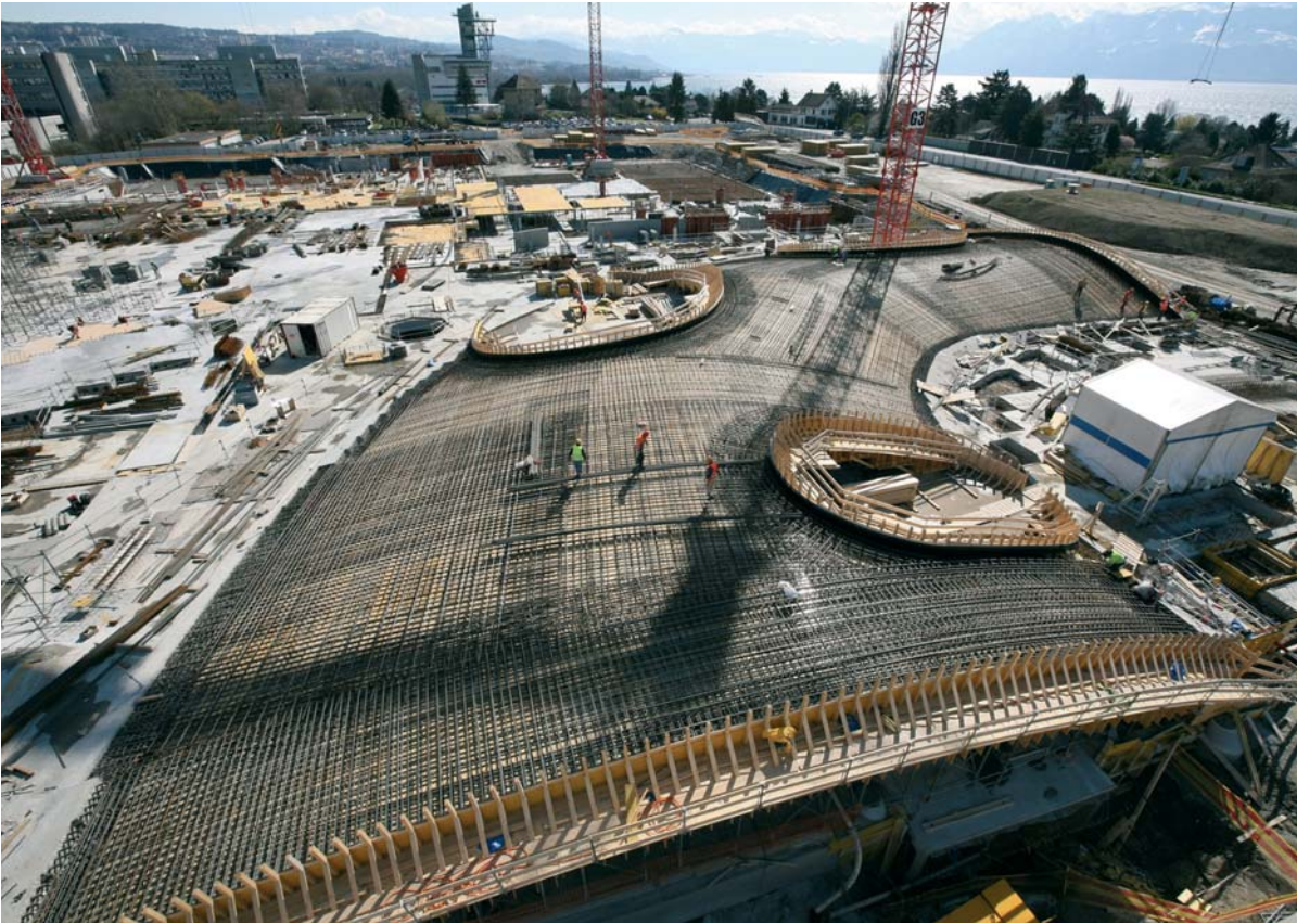
Fig. 8 Bewehrungsanordnung (© Alain Herzog). Shell reinforcement (© Alain Herzog).
