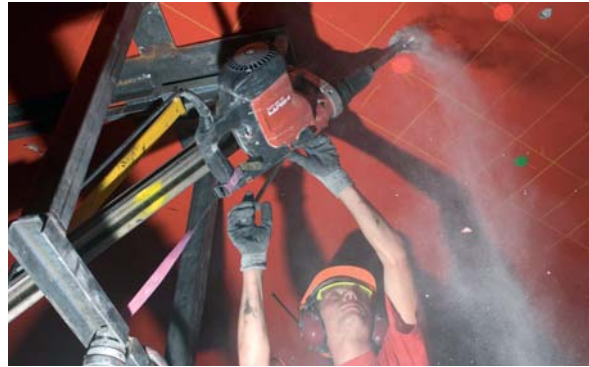
Fig. 6 Réalisation des forages. Drilling the holes.
