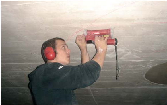
Fig. 5 Marquage des armatures inférieures de la dalle. Marking the lower reinforcement of the slab.
