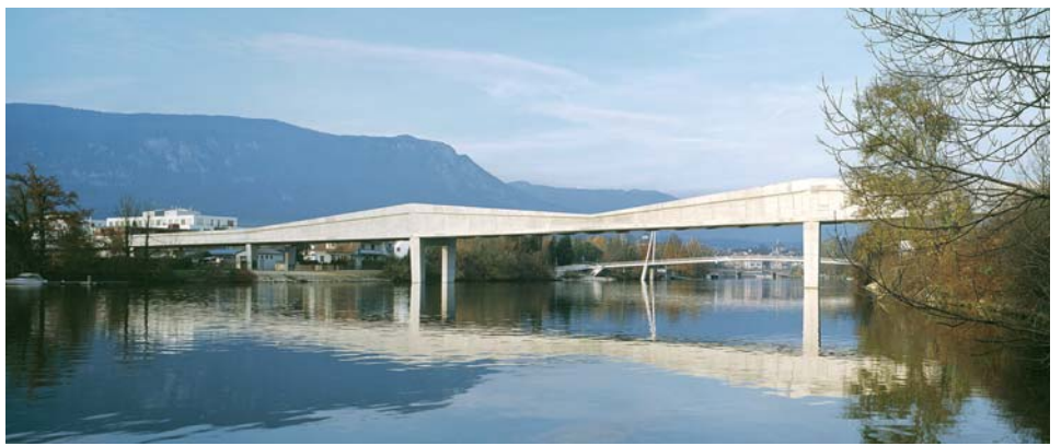
Fig. 4 Aarebrücke: Ansicht von der Oberwasserseite. Aare bridge: view from upstream.
