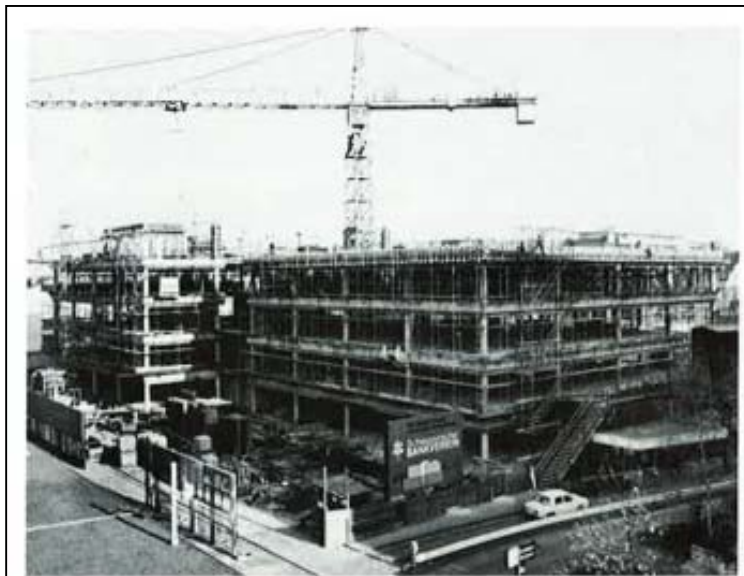
Bild 1. Rohbau Bürogebäude Schweizerischer Bankverein
