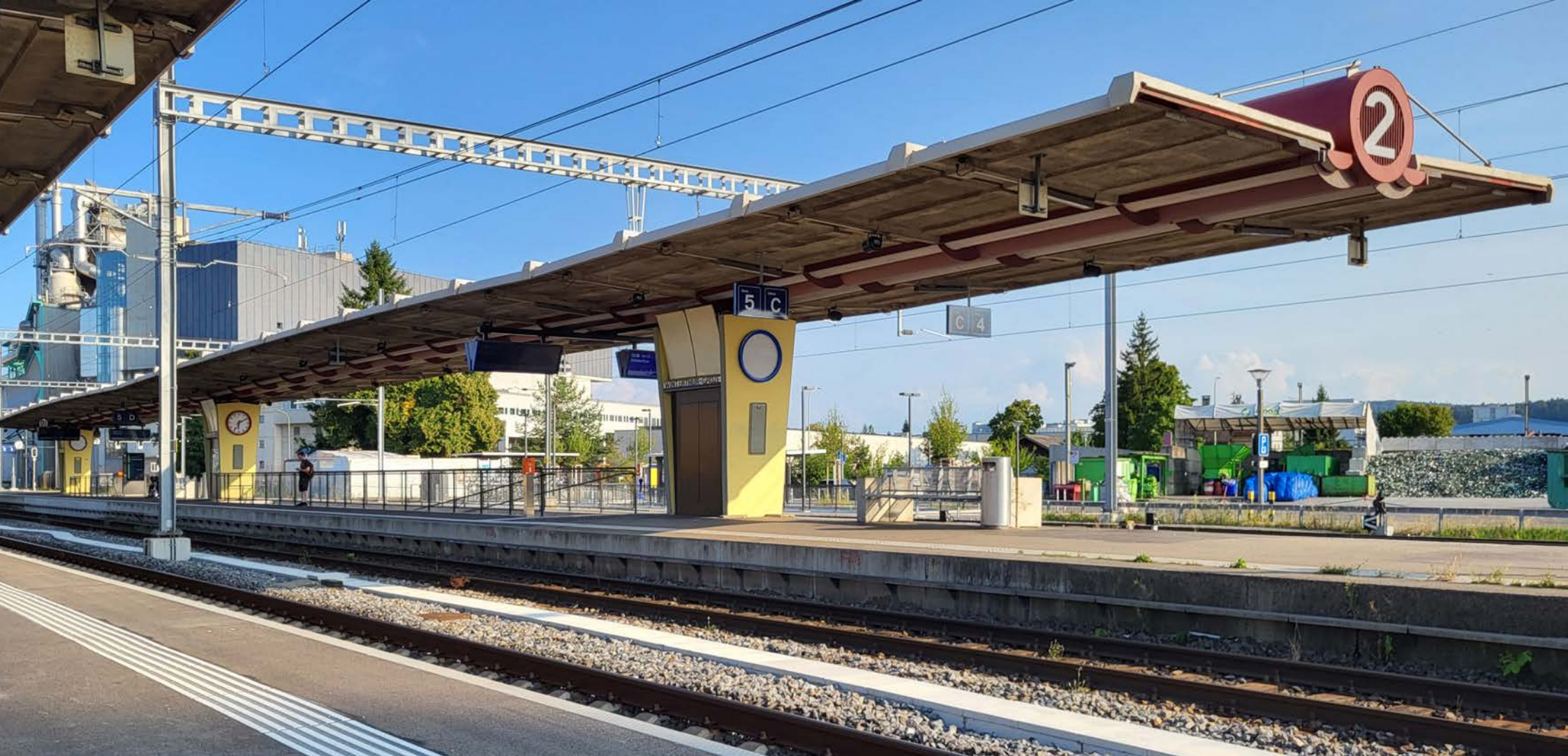
Das Perrondach in Winterthur-Grüze nach der Instandsetzung, 2025. Die Konstruktion ist immer noch original.
