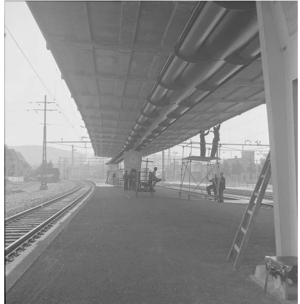
Abschlussarbeiten am Dach, deren Platten für ein Perron in nur rund 4 Stunden montiert werden konnten - 3. August 1954.
