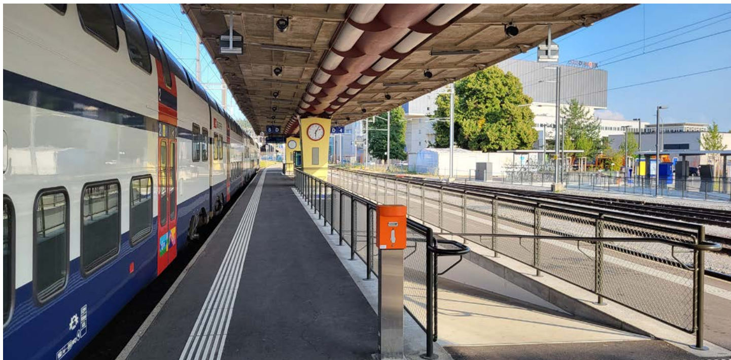
Das Perrondach nach der gesamthaften Instandsetzung der bewitterten Flächen von 2025.
