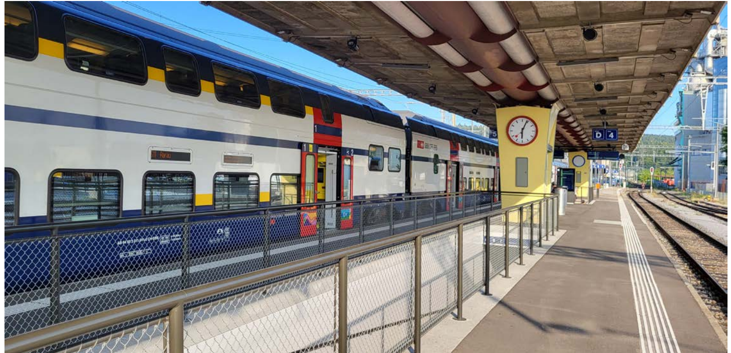
Das Perrondach in Winterthur-Grüze nach der Instandsetzung 2025, bei der auch die Untersicht und die Beleuchtung erneuert wurden.
