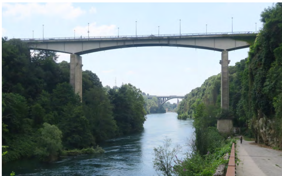
Figure 5.6 : Le viaduc de Trezzo sur l'Adda, vue vers le sud, en 2021 : une « malheureuse » transformation. Seules les fondations d'origine subsistent. Les piles métalliques ont été enrobées de béton. A l'arrière-plan, le pont de l'autoroute Milan – Venise.
