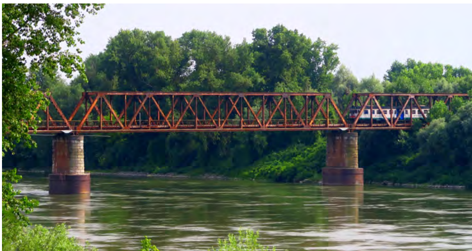
Figure 5.14 : Le pont de Casalmaggiore sur le Pô avec un train régional reliant Parme à Brescia, vue vers l'aval, depuis la rive gauche, en 2021. Les fondations sont d'origine. La plus grande partie du pont franchit la zone inondable.
