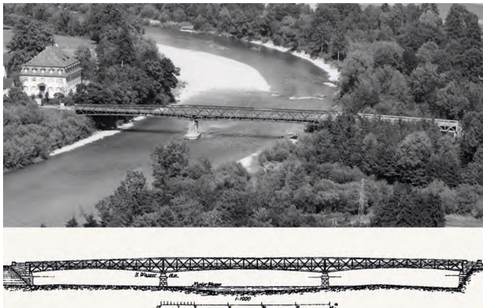
Figure A2.8 : Pont routier sur la Thur, près d'Oberbüren, dans le canton de Saint-Gall (coord : 47.45539N, 9.15175E), construit en 1886. Photographie aérienne de 1958 et plan présenté dans la SBZ (ETHZ Bibliothek).
