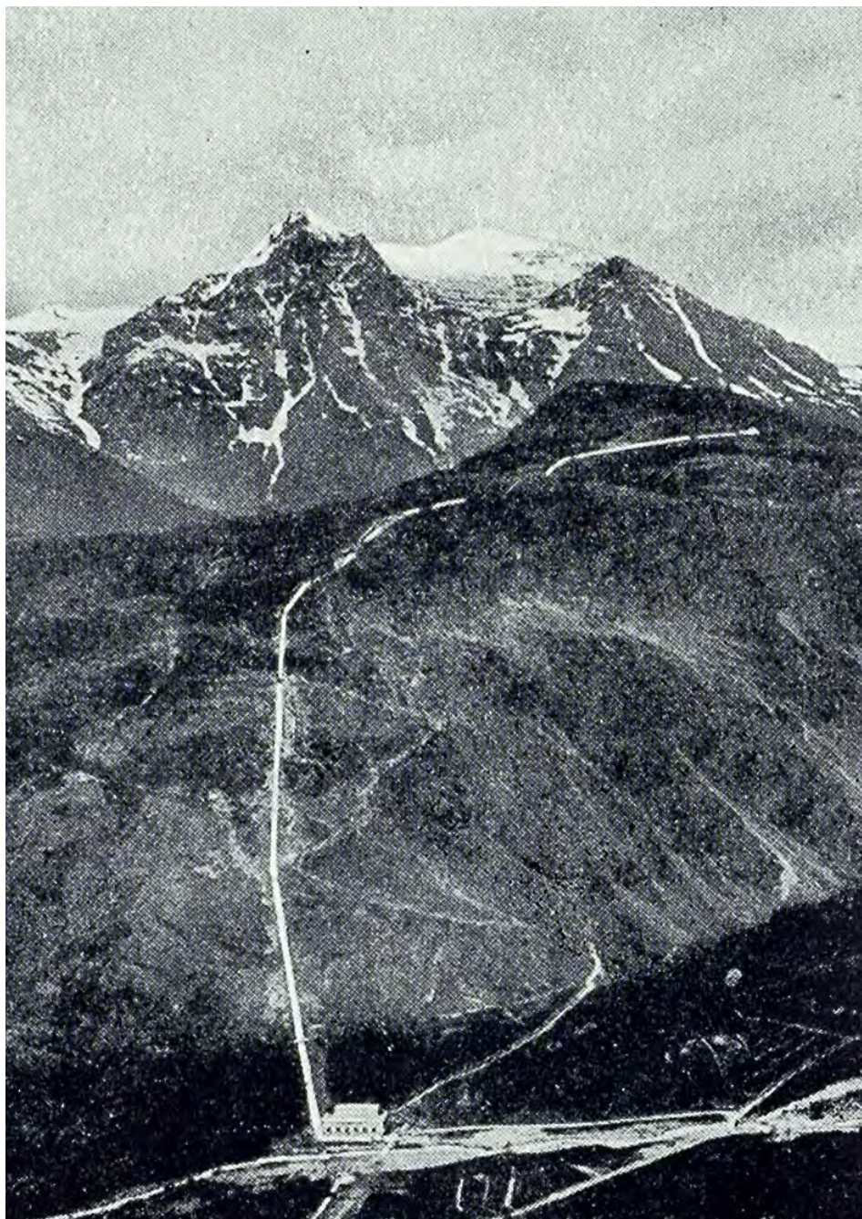
Figure A2.11 : Conduite forcée avec une chute de 442 m et la centrale hydroélectrique de Noalesa (coord. localité : 45.18922N, 7.01509E), en amont de Venaus, située près de Susa, dans le Piémont. Elle turbine les eaux de la Cenischia / Cenis, qui prend sa source sur le plateau du Mont-Cenis, alors en Italie. La centrale est ouverte en 1901 (SNOS, 1914).
