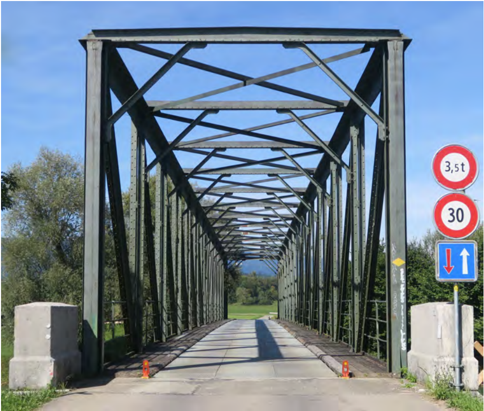
Figure 3.9 : Portail du pont de Walperswil sur le canal de Hagneck entre Aarberg et le lac de Biene, en 2025. Le pont d'une portée de 79 m est construit par Ott & Cie en 1877-1878, projeté probablement par Röthlisberger.
