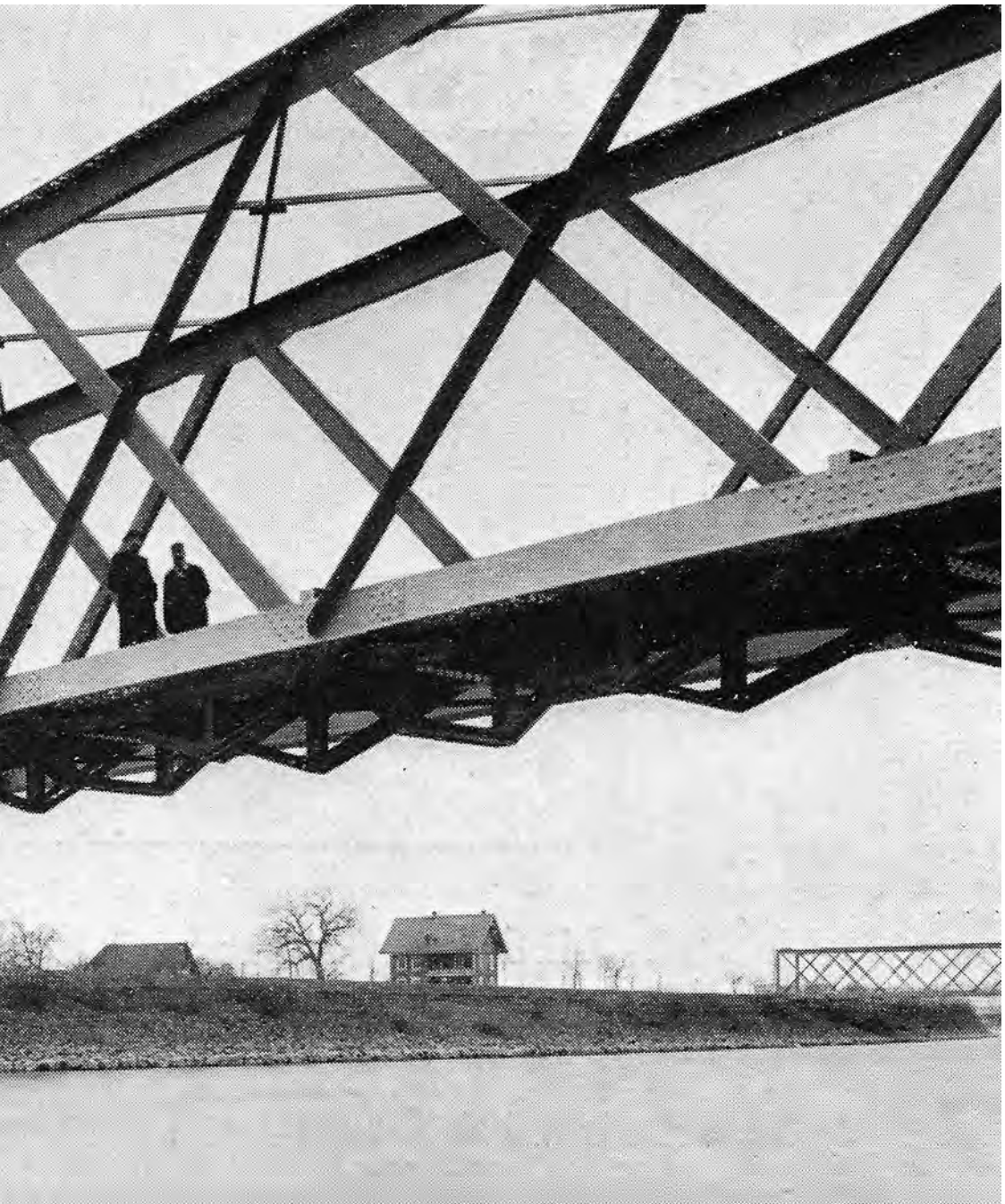
Figure 3.12 : Pont ferroviaire de Brügg, sur le canal de dérivation de l'Aar (ancienne Thièle) entre Nidau, au bord du lac de Bienne, et Büren, construit également dans le cadre de la correction des eaux du Jura en 1877-1878, projeté probablement par Röhliberger (Bühler, Die Brückenbauten der SBB , 1926, p. 35). L'ouvrage, long de 110 m, est situé sur la ligne Bienne-Berne. La superstructure est remplacée en 1928.
