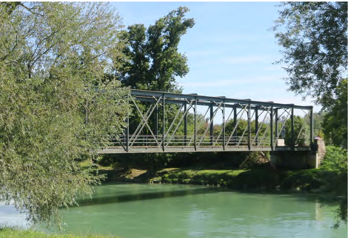
Figure 3.11 (en bas) : Vue en 2025 du pont de Walperswil sur le canal de Hagneck de dérivation de l'Aar dans le lac de Bienne. C'est apparemment le seul des nombreux ponts d'une seule travée construits par Ott & Cie, conservé à ce jour.
