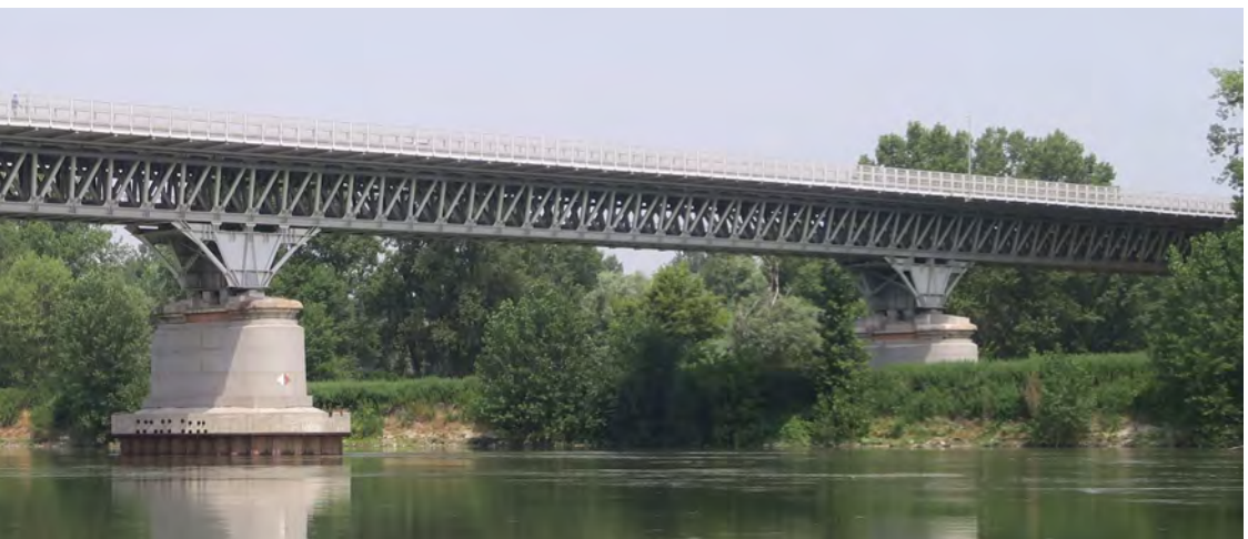
Figure 8.18 (en bas) : Le pont routier de Plaisance sur le Pô, reconstruit en 2010 sur les fondations d'origine et surélevé pour prévenir les effets de crues exceptionnelles, vue depuis la rive droite vers le nord, en 2021.
