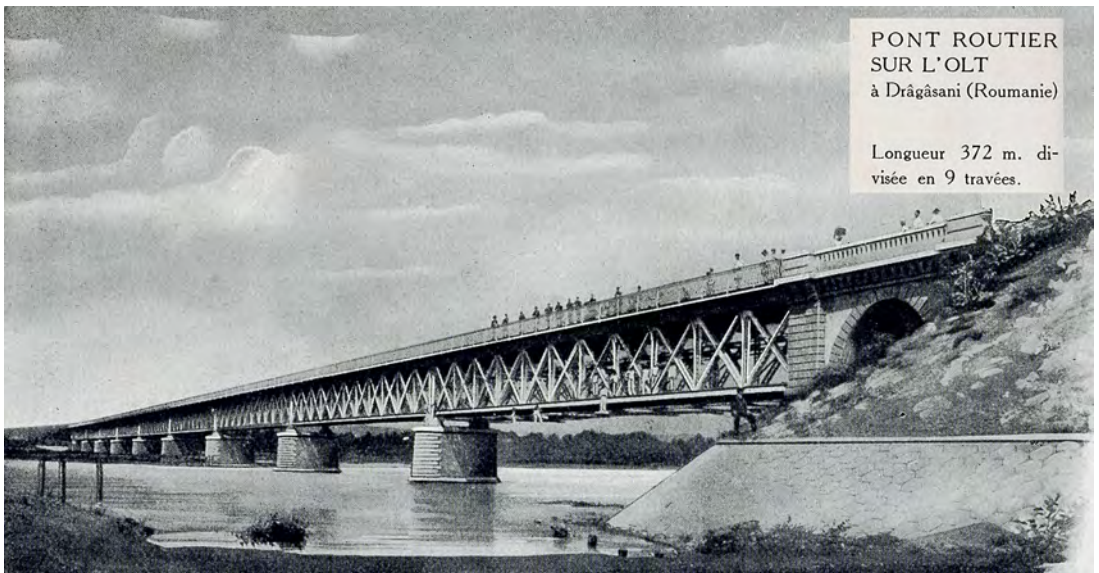
Figure 8.5 : Pont routier sur l'Olt à Drăgășani en Roumanie (coord. : 44.66269N, 24.30027E), long de 372 m, divisé en 9 travées (SNOS, 1914). Le pont, construit en 1901, fut réparé après sa destruction en novembre 1916 par l'armée roumaine en retraite. Il est toujours en service avec une circulation alternée.
