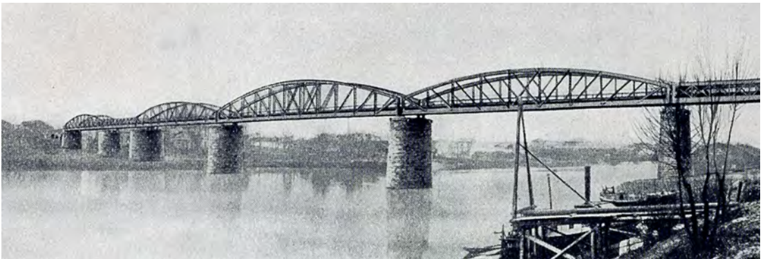
Figure 8.7 : Le pont ferroviaire d'Ujpest sur le petit bras du Danube en Hongrie, long de 226 m, vue en direction du nord (SNOS, 1914).
