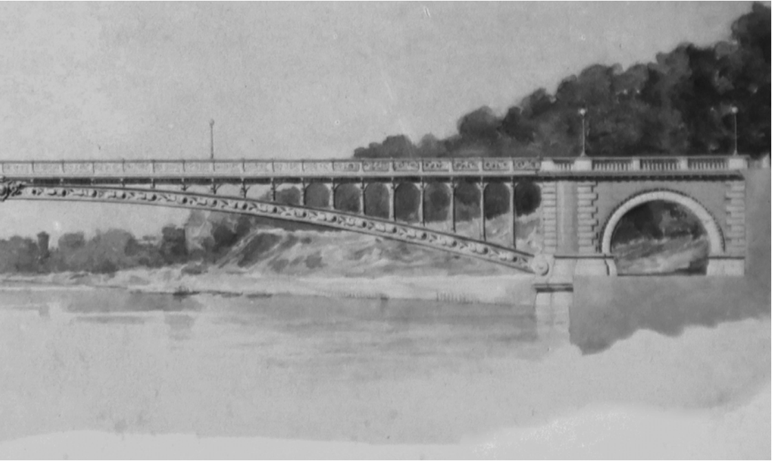
Fig. 8.2 : Projet de pont Maria Teresa à Turin sur le Pô, présenté par la SNOS. L'arche a une corde de 90,4 m, avec une flèche de 6,2 m. La largeur du pont, situé en prolongement du Corso Vittorio Emanuele II, est de 20 m (SNOS, 1893, ASTo).
