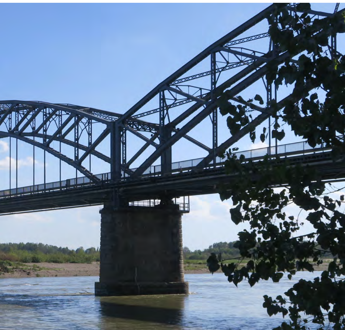
Figure 8.23 : Pont de la Gerola sur le Pô en 2025. Il est divisé en huit travées soutenues par des arches d'une portée de 94 m environ.
