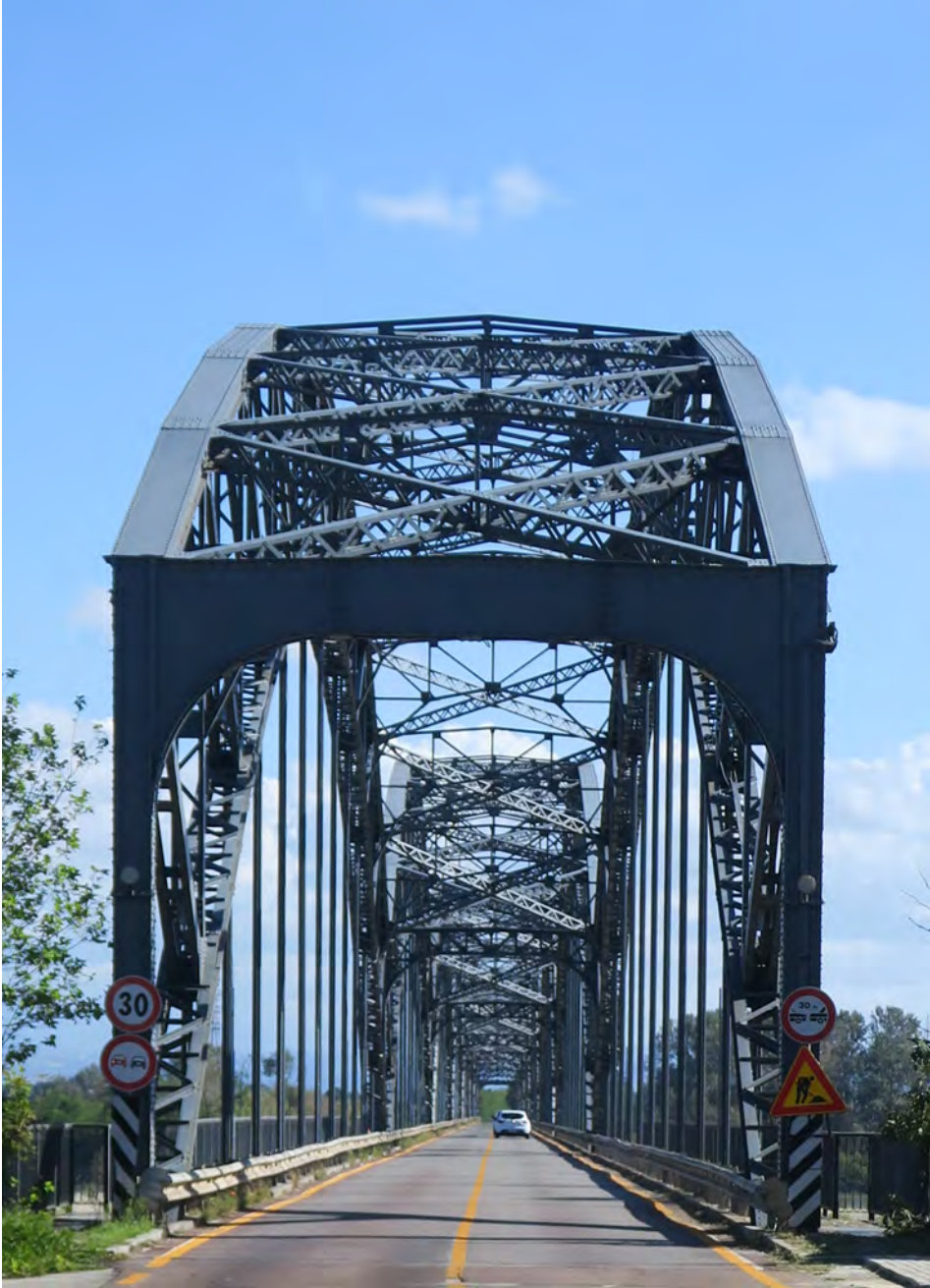
Figure 8.24 : Portail du pont de la Gerola sur le Pô en 2025, vers depuis la rive gauche vers le sud
