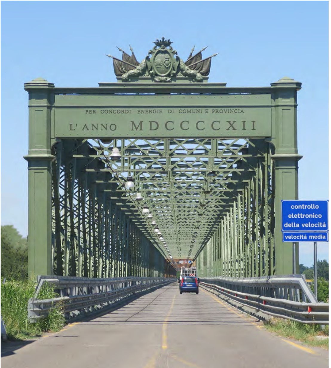
Figure 8.21 : Portail du pont routier della Becca au confluent du Pô et du Tessin en 2021, vue vers le nord. Le pont fut inauguré en 1912.
