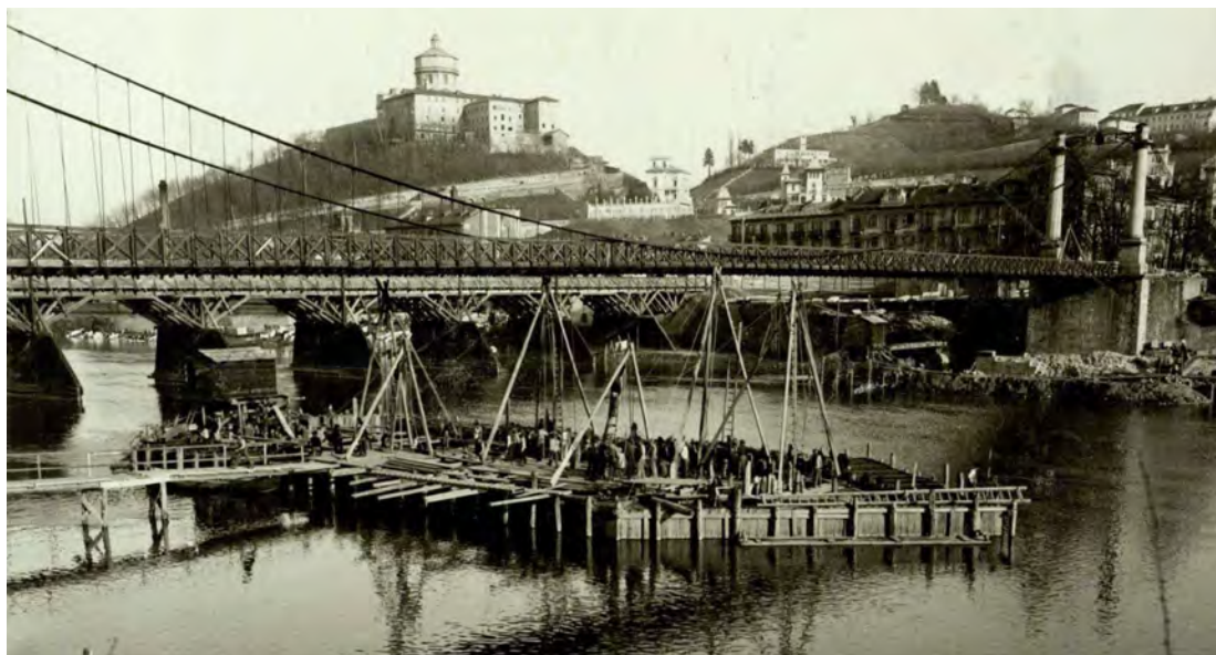
Fig. 8.4 : Vers 1904, pont suspendu Maria Teresa sur le Pô à Turin, au début des travaux de construction du pont en pierre Umberto I. Derrière, à l'aval, pont provisoire (Allegri & Co, 1907, Polito).
