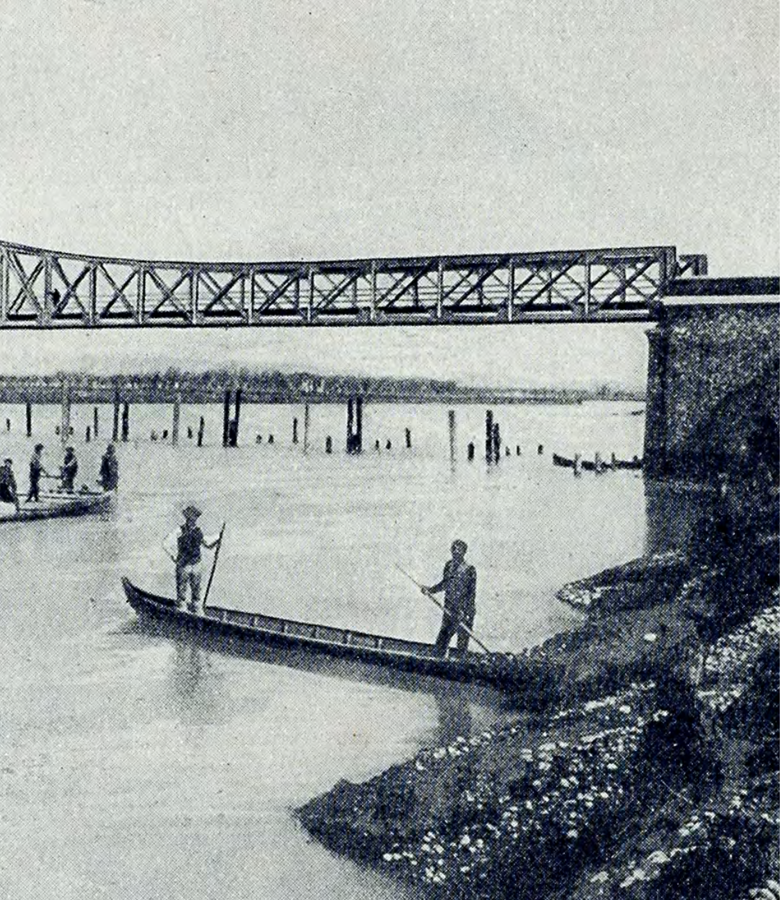
Fig. 8.3 : Pont sur le Tanaro près d'Asti (44.88803N, 8.22523E) pour la ligne ferroviaire Asti-Ovada-Gênes. Il est construit en acier. Sa longueur est de 157,5 m avec trois travées de 48,75 – 60 – 48,75 m. Le tronçon Asti-Ovada est ouvert le 19 juin 1893 (SNOS, 1906 et 1914).
