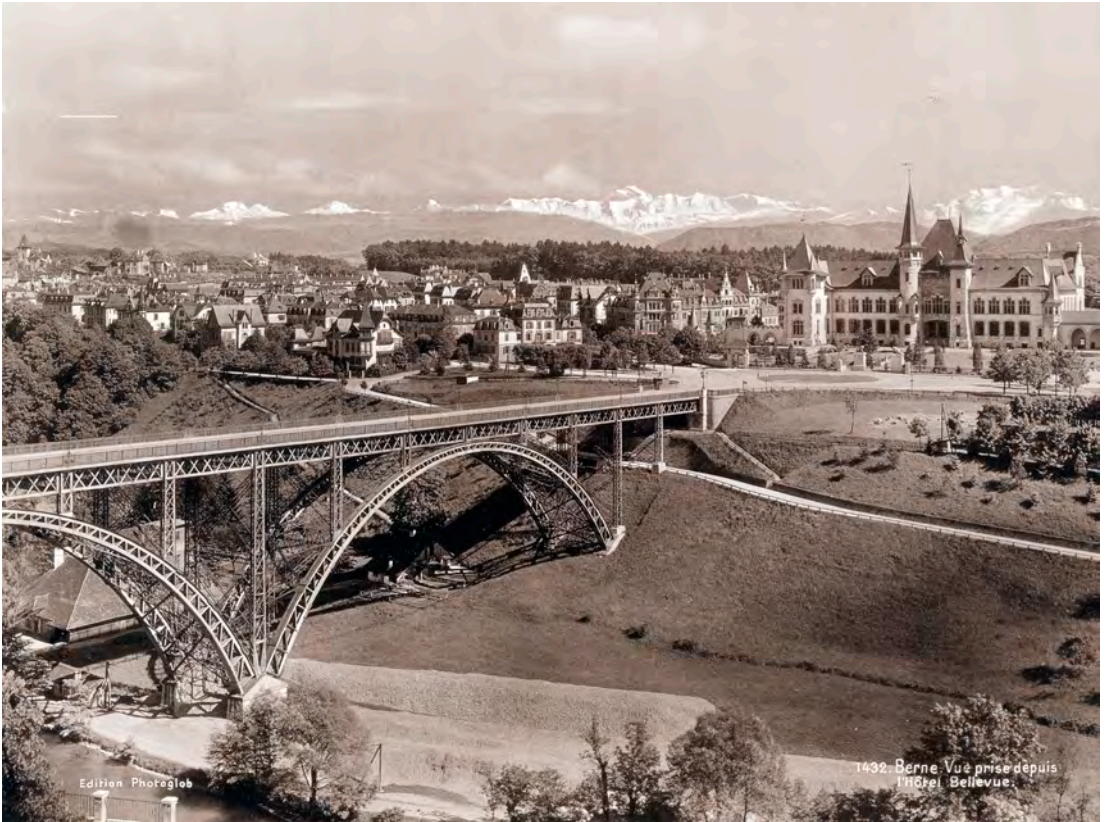
Figure 3.36: Pont du Kirchfeld vers 1900 avec vue sur le la Helvetiaplatz, le musée de Berne et les Alpes bernoises, Les piles principales ont encore une structure métallique (ETHZ Bibliothek).
