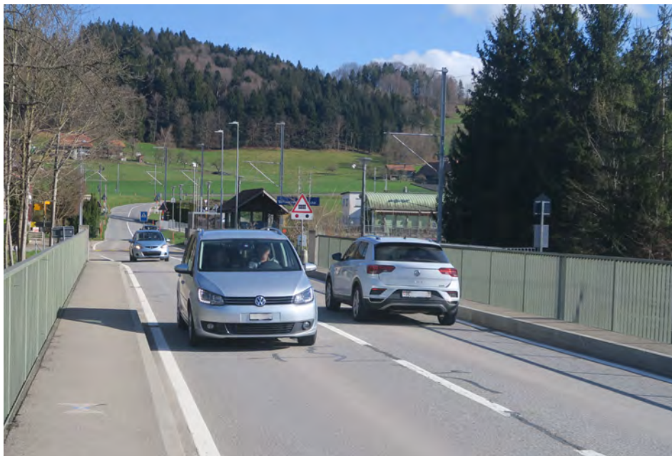
Figure 3.27 : Pont sur la Schwarzwasser en 2022. Il n'a aucune restriction de circulation.
