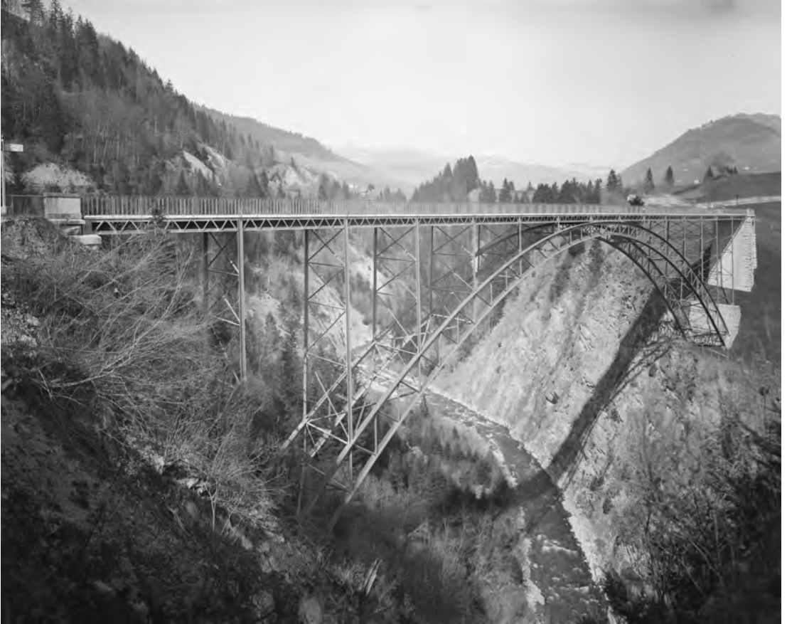
Figure 3.21 : Pont routier du Javroz ouvert à la circulation en 1881. La photographie est prise vers 1900 (Archives de l'Etat de Fribourg).
