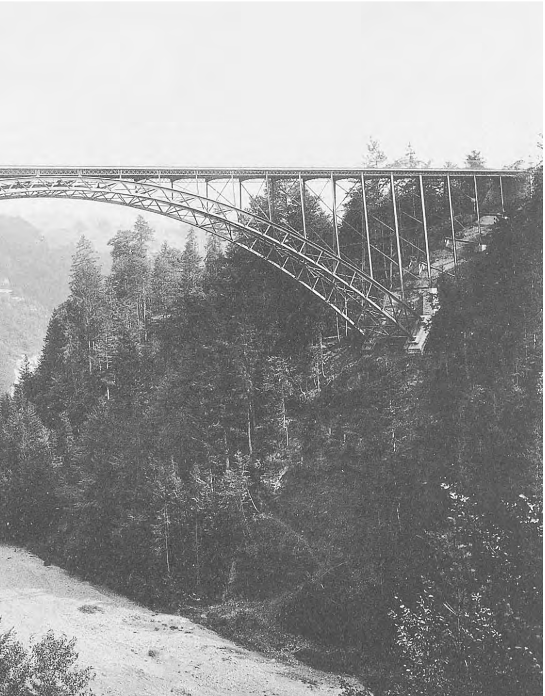
Figure 3.26 : Pont sur la Schwarzwasser vers 1884 (SBZ, 6 décembre 1884, ETHZ Bibliothek).
