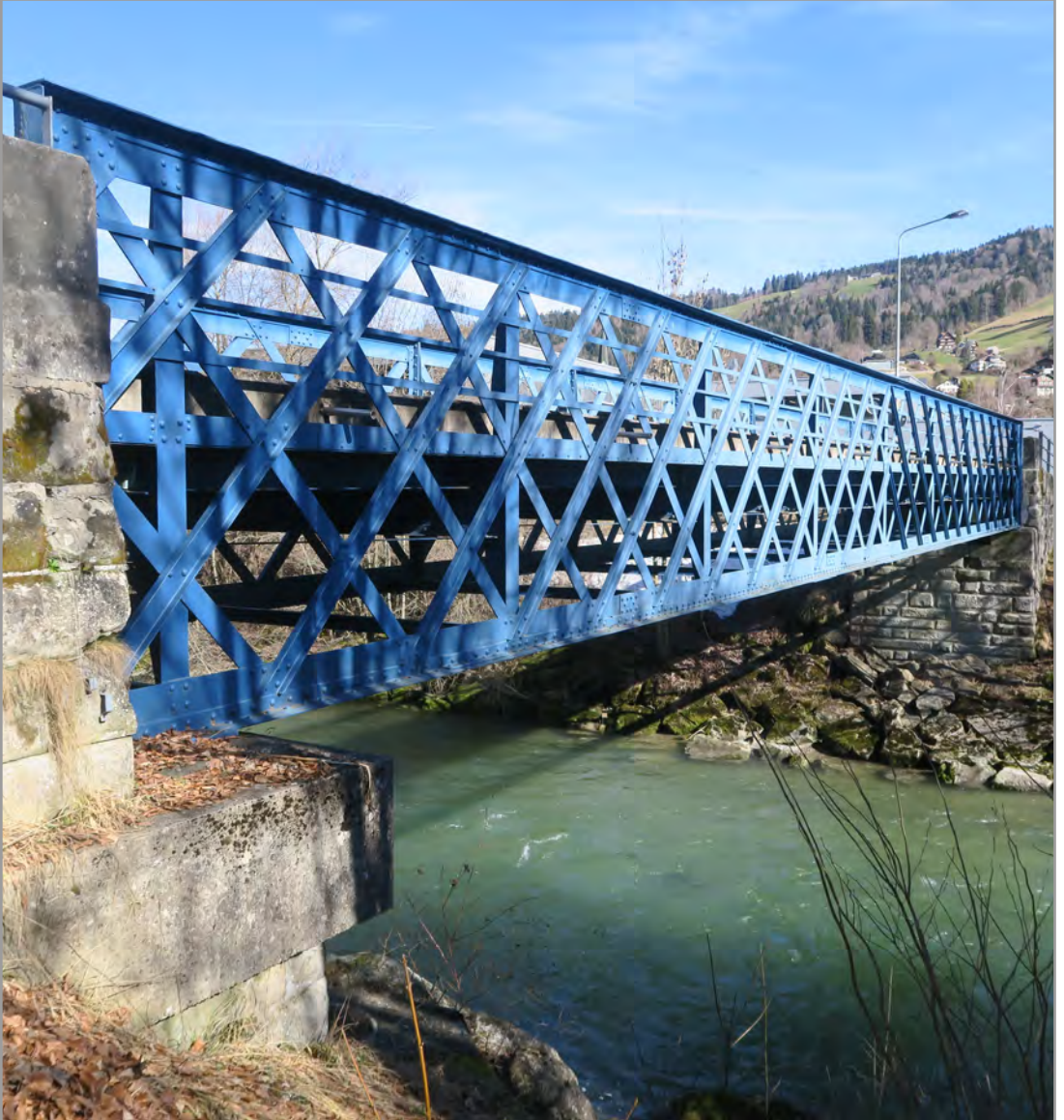
Figure A1.14 : Pont routier aval de l'Industriestrasse-Ganten sur la Thur pour l'accès à la gare d'Ebnat-Kappel, en 2026, construit en 1872 par Beat Gubser. Sa longueur est de 30,7 m et sa largeur de 3,4 m.
