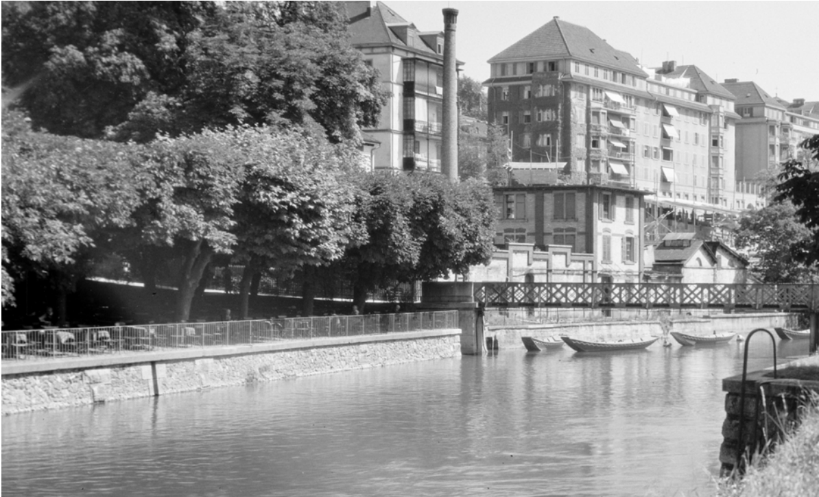
Figure A1.16 (en haut) : Passerelle de Drahtschmidlisteg à Zurich sur la Limmat – vue vers l’amont – en août 1932 construite en 1877 par Beat Gubser (Archives de la construction de Zurich). Elle relie la rive droite au parc de Platzspitz. Sa portée est de 78 m avec trois travées, posées sur des pieux. Elle est remplacée vers 1985.
