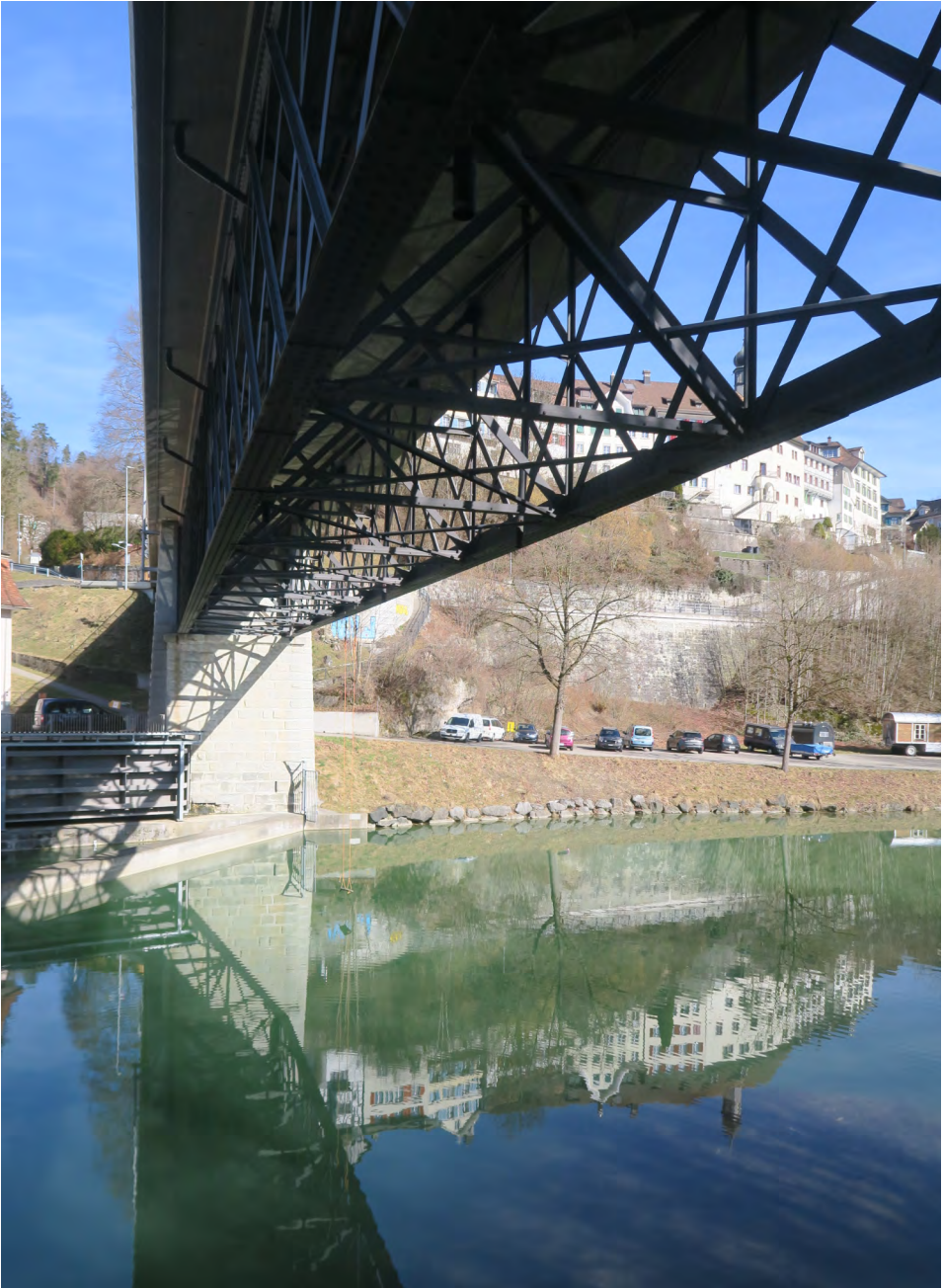
Figure A1.11 : Pont routier Stadtbücke de Lichtensteig sur la Thur, construit en 1870 par Beat Gubser, en 2026. Sa longueur est de 100 m. La travée centrale a une portée de 42 m.
