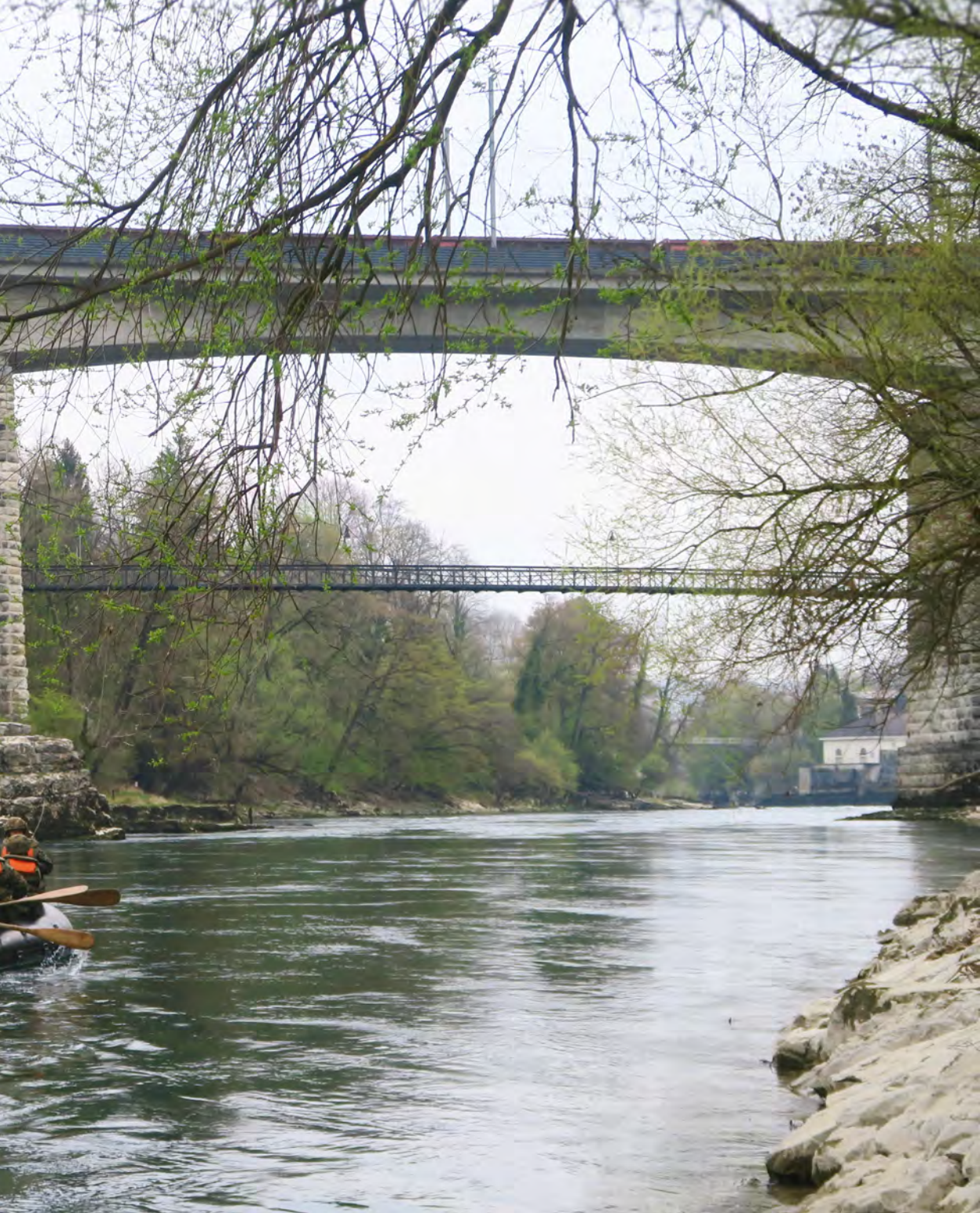
Figure A1.22 : Pont de Brugg sur l'Aar en 2019. Les poutres métalliques de 1905 sont remplacées en 1996 par une structure en béton en perspective de l'ouverture de la ligne de base du Gothard. La passerelle piétonne et les piles sont d'origine (1875-1876).
