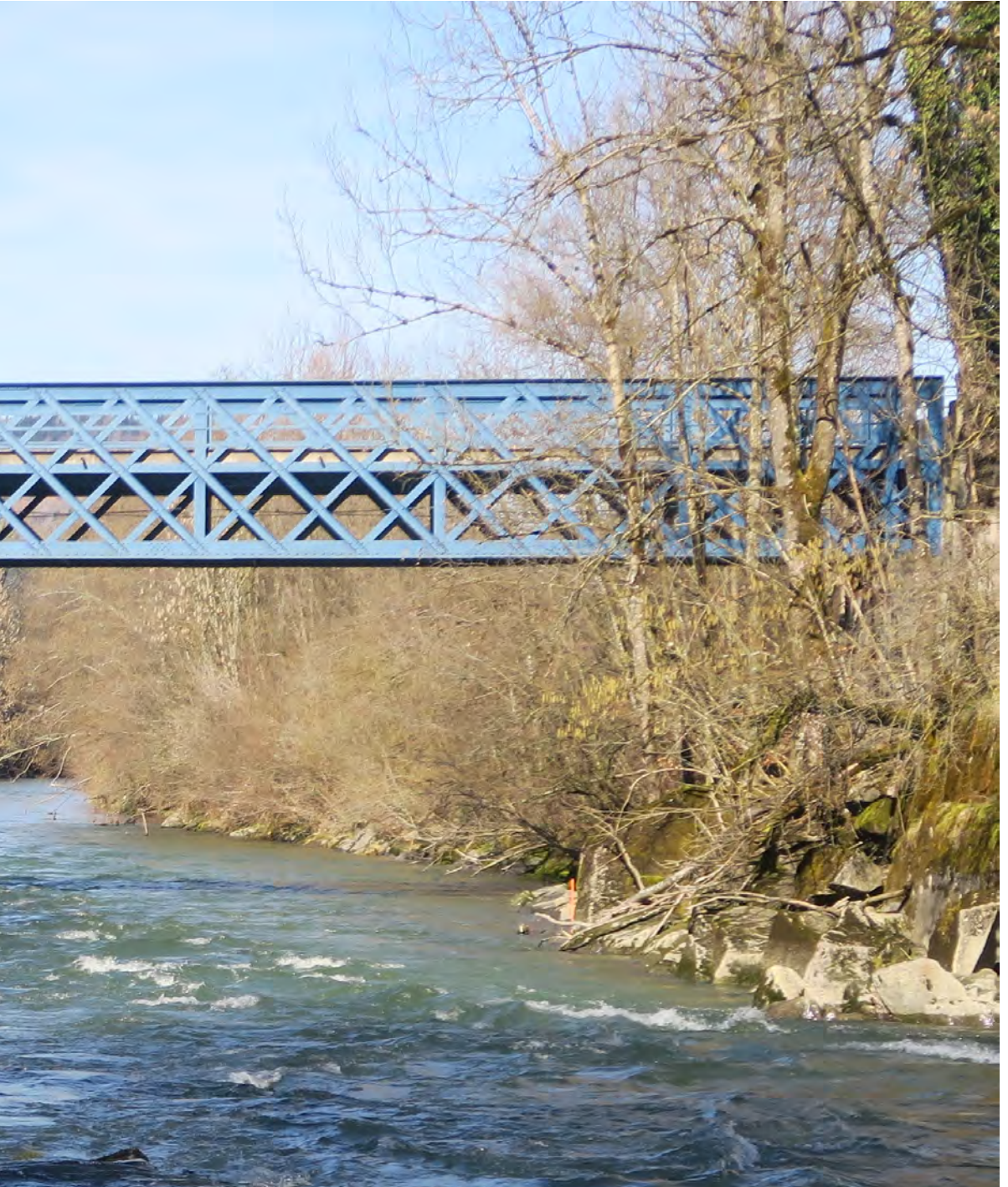
Figure A1.15 : Pont routier aval de l'Industriestrasse-Ganten sur la Thur, en 2026, construit en 1872 par Beat Gubser. Sa longueur est de 30,7 m.
