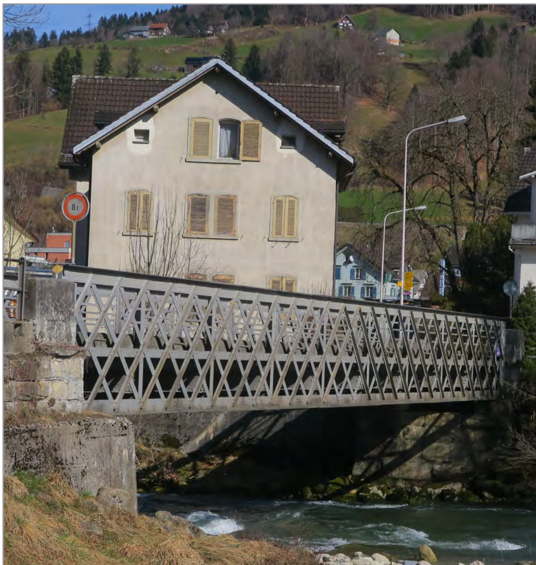
Figure A1.13 : Pont routier amont de l'Industriestrasse-Eichstrasse sur la Thur pour l'accès à la gare d'Ebnat-Kappel, en 2026, construit en 1872 par Beat Gubser. Sa longueur est de 28,5 m et sa largeur de 3.3 m.
