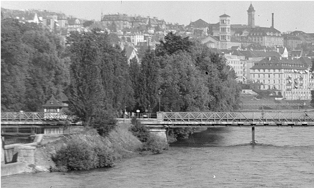
Figure A1.16 (en haut) : Passerelle de Drahtschmidlisteg à Zurich sur la Limmat – vue vers l’amont – en août 1932 construite en 1877 par Beat Gubser (Archives de la construction de Zurich). Elle relie la rive droite au parc de Platzspitz. Sa portée est de 78 m avec trois travées, posées sur des pieux. Elle est remplacée vers 1985.
