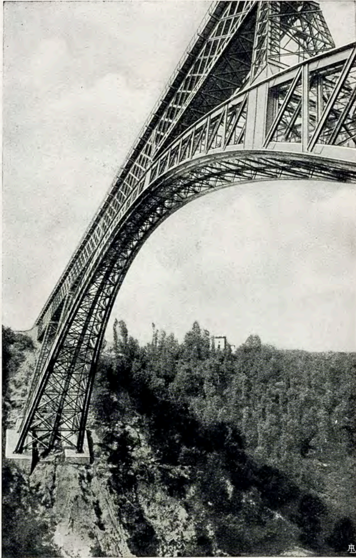
VIADUC DE PADERNO SUR L'ADDA
