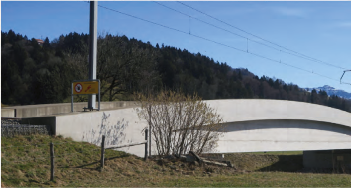
Pont reconstruit en 2019 en béton
