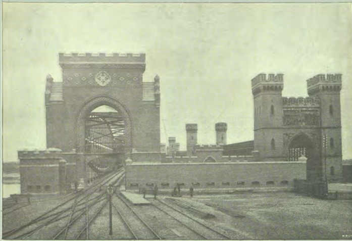
Portale der alten und neuen Weichselbrücke in Dirschau.
