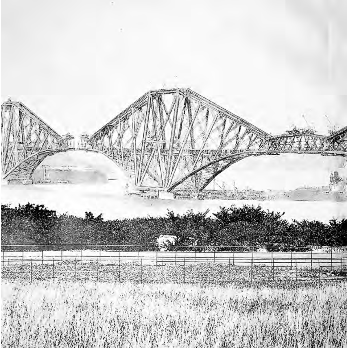
Figure 10.6 : Le pont de la Forth (coord. : 56.00108N, 3.38864W). Tiré à part du journal Engineering , le 28 février 1890. La planche IV présente la vue générale du pont, la poutre centrale sud est reliée aux deux porte-à-faux ; la poutre centrale nord est encore inachevée (archives de famille).
