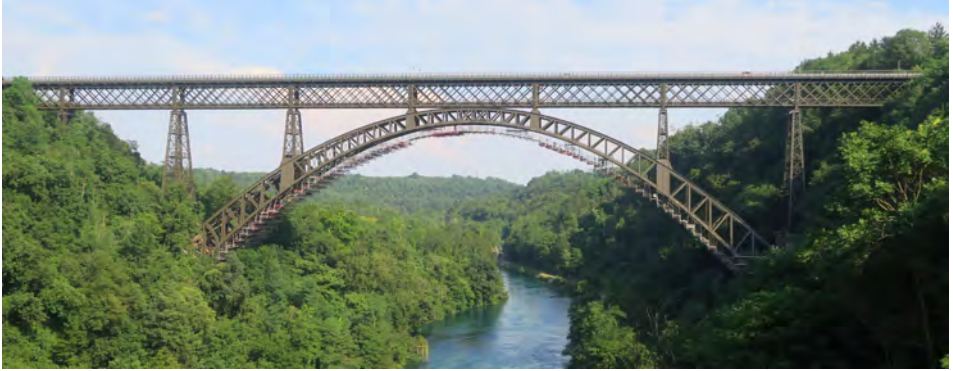
Figure 5.28 : Paderno sur l'Adda / San Michele, Italie, Jules Röthlisberger 1887-1889, portée de l'arche : 150 m, encastrée aux appuis, fer puddlé (coord. : 45.68235N, 9.45236E).
