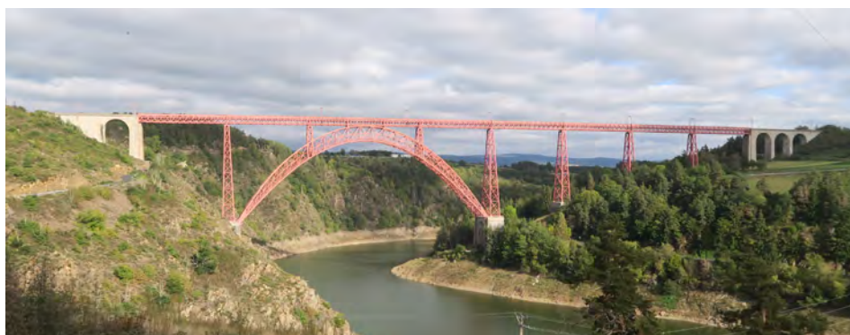
Figure 5.26 : Garabit, Cantal, France, Gustave Eiffel et Maurice Koechlin, 1880-1884, portée de l'arche : 165 m, proposé par Léon Boyer, articulations aux appuis, fer puddlé (coord. : 44.97570N, 3.17721E).
