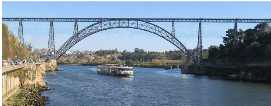
Figure 5.25 : Maria Pia, Porto, Gustave Eiffel et Théophile Seyrig, 1875-1877, portée de l'arche : 160 m, articulations aux appuis, fer puddlé (coord. : 41.13971N, 8.59722W).
