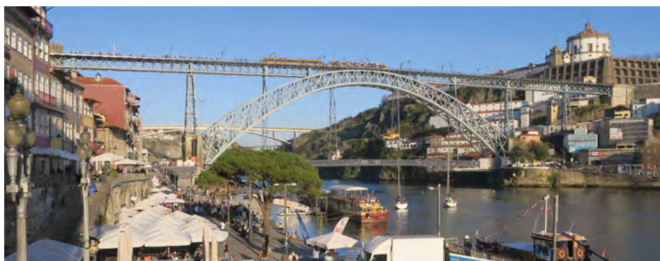
Figure 5.27 : Dom Luis, Porto, Théophile Seyrig 1881-1886, portée de l'arche : 172 m, articulations aux appuis, fer puddlé (coord. : 41.14000N, 8.60945W).
