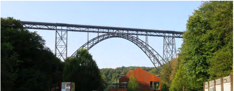
Figure 5.29 : Müngsten, Rhénanie du nord-Westphalie, Anton von Rieppel, 1893-1897, portée de l'arche : 170 m, encastrée aux appuis, acier (coord. : 51.16047N, 7.13348E).
