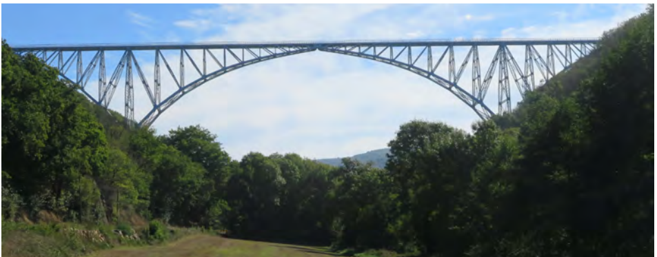
Figure 5.30 : Viar, Tarn et Aveyron, France, Paul Bodin 1895-1902, portée de « l'arche » : 220 m, deux porte-à-faux équilibrés, acier (coord. : 44.12368N, 2.33119E).
