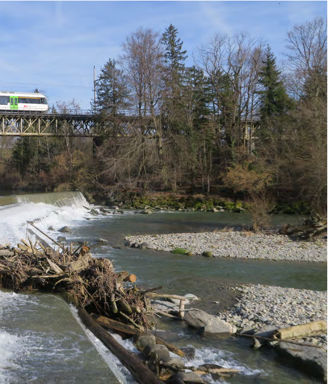
Figure A1.34 : Pont ferroviaire de Sitterdorf sur la Sitter, en 2026, long de 135,6 m, quatre travées – 32,1 m / 35,7 m / 35,7 m / 32,1 m –, construit par Beat Gubser en 1875, rénové la dernière fois en 2007.
