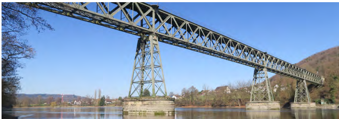
Figure A1.27 : Pont d'Hemishofen (canton de Schaffhouse) sur le Rhin, en 2026, mis en service en 1875, long de 252 m, n'est plus utilisé depuis 1969 en trafic voyageurs et depuis 1996 en trafic marchandises (coord. : 47.67274N, 8.83419E).
