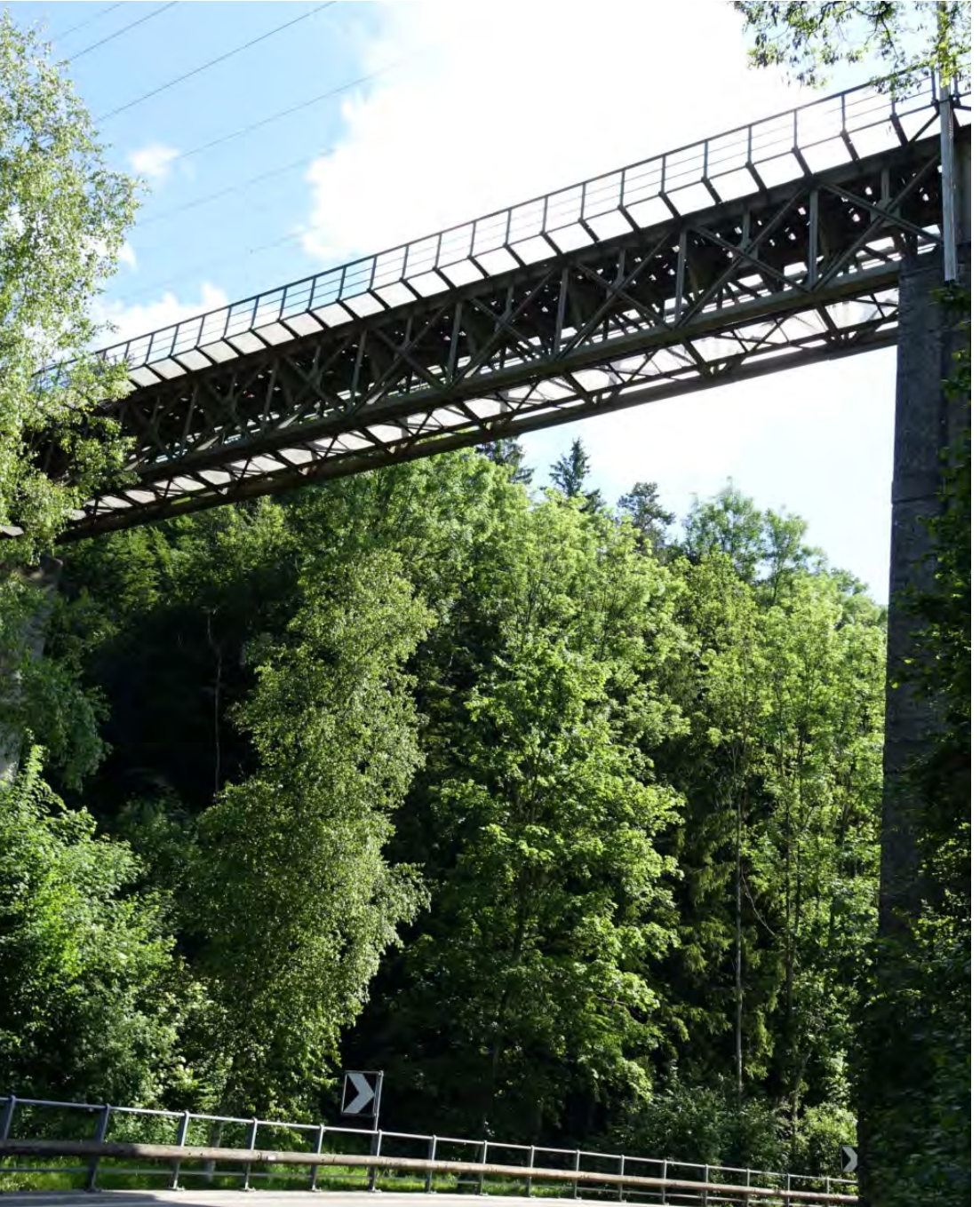
Figure A1.28 : Pont ferroviaire de Sorntal (canton de Saint-Gall), construit en 1875-1876 par Beat Gubser. Il est le troisième plus ancien pont ferroviaire toujours en service en Suisse, avec le pont de Sitterdorf. Il est rénové la dernière fois en 2007 (site du bureau d'ingénieurs Borgogno Eggenberger + Partner).
