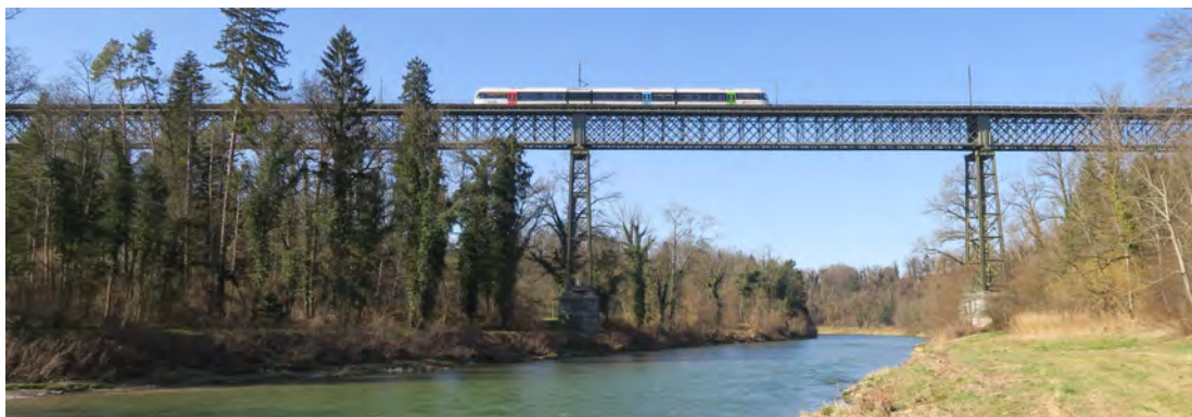
Figure A1.26 : Pont d'Ossingen (canton de Zurich) sur la Thur, en 2026, ouvert en 1875 et long de 330 m. Il est le deuxième plus ancien pont métallique ferroviaire toujours en service en Suisse (coord. : 47.60171N, 8.72366E).
