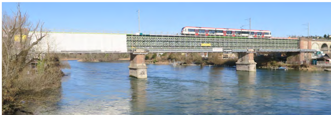
Figure A1.25 : Pont entre Koblenz (canton d'Argovie) et Waldshut (Allemagne) sur le Rhin, en 2026, mis en service en 1858 et long de 190 m. Il est le plus ancien pont métallique ferroviaire, toujours en service en Suisse (coord. : 47.60925N, 8.23410E).
