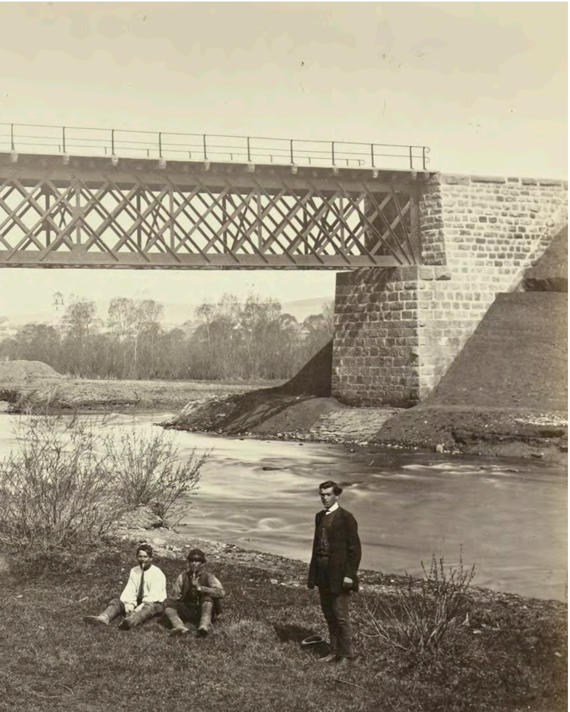
Figure A1.36: Pont sur la Hernád de la ligne Kaschau / Kassa / Košice – Oderberg / Bohumin, construit en 1871, de mêmes dimensions que celui de Margecany, présenté à la figure A1.37 (ETHZ Bibliothek).
