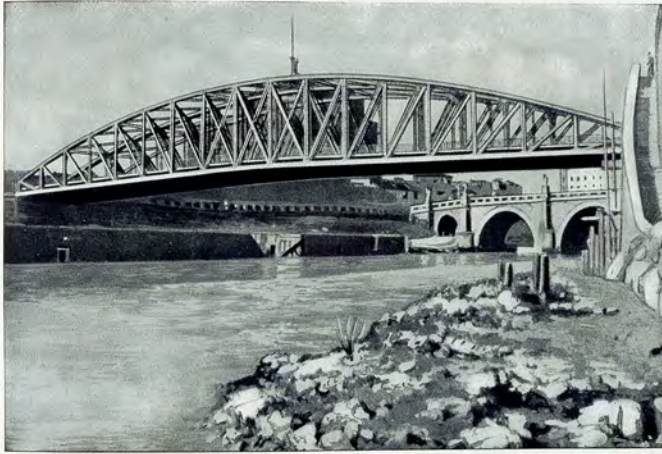
DOUBLE PONT PROVISOIRE SUR LE TEVERE à Rome, Place Pia
