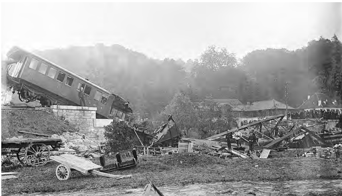
Figure 6.3 : Photographie qui a servi de modèle pour la lithographie. A gauche, la culée du pont qui fut affouillée lors des inondations de septembre 1881, puis reconstruite en 1882. Dans l'intervalle, le pont reposait sur des palées provisoires (Staatsarchiv Basel-Stadt, NEG 02129).
