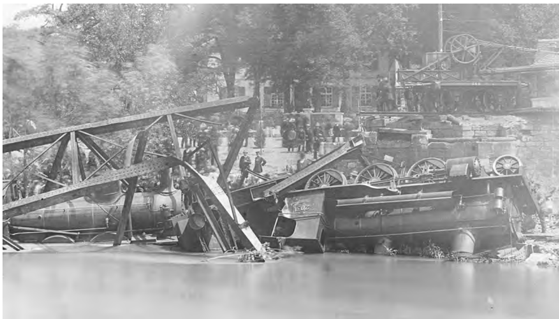
Figure 6.4 : Pont effondré de Mönchenstein vue vers l'aval. La locomotive de tête renversée est à droite (Staatsarchiv Basel-Stadt, NEG 06291).
