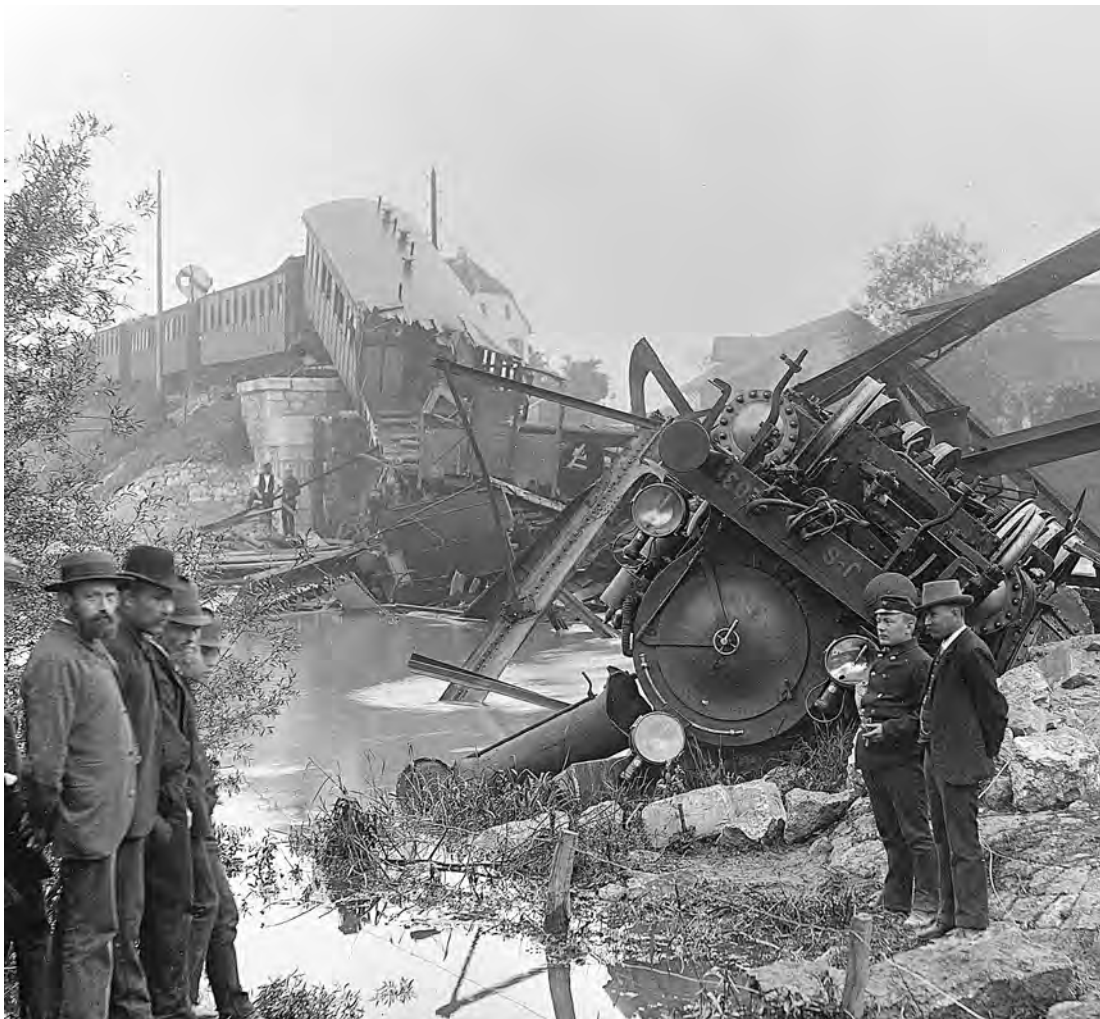
Figure 6.1 : Vue vers l'aval depuis la rive droite de la Birse, côté Mönchenstein. Les freins automatiques à air comprimé Westinghouse ont retenu les derniers wagons. La voiture de renfort de 1 ère et 2 e classe pend sur la culée. La première machine a fait un quart de tour (Staatsarchiv Basel-Stadt, NEG 02127).
