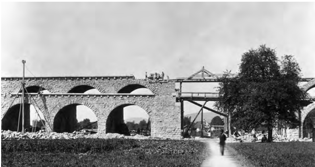
Figure 7.9 : Construction en 1892 du viaduc de l'Aussersihl sur la future Heinrichstrasse (coord. : 47.38741N, 8.52562E). La NOB a préparé les culées pour les ponts métalliques réalisés par la SNOS (Baugeschichtliches Archiv Zürich).
