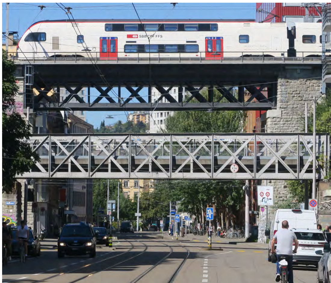
Figure 7.14 : Ponts de 1894 sur la Limmatstrasse (coord. : 47.38789N, 8.52706E), vue vers l'ouest, en 2025. La gare centrale de Zurich se trouve du côté gauche de la photographie. La ligne surélevée à double voie dessert, vers la droite, Wipkingen ; le pont est rénové en 2024. Au premier-plan, le pont à simple voie qui desservait les gares de Letten et de Stadelhofen.
