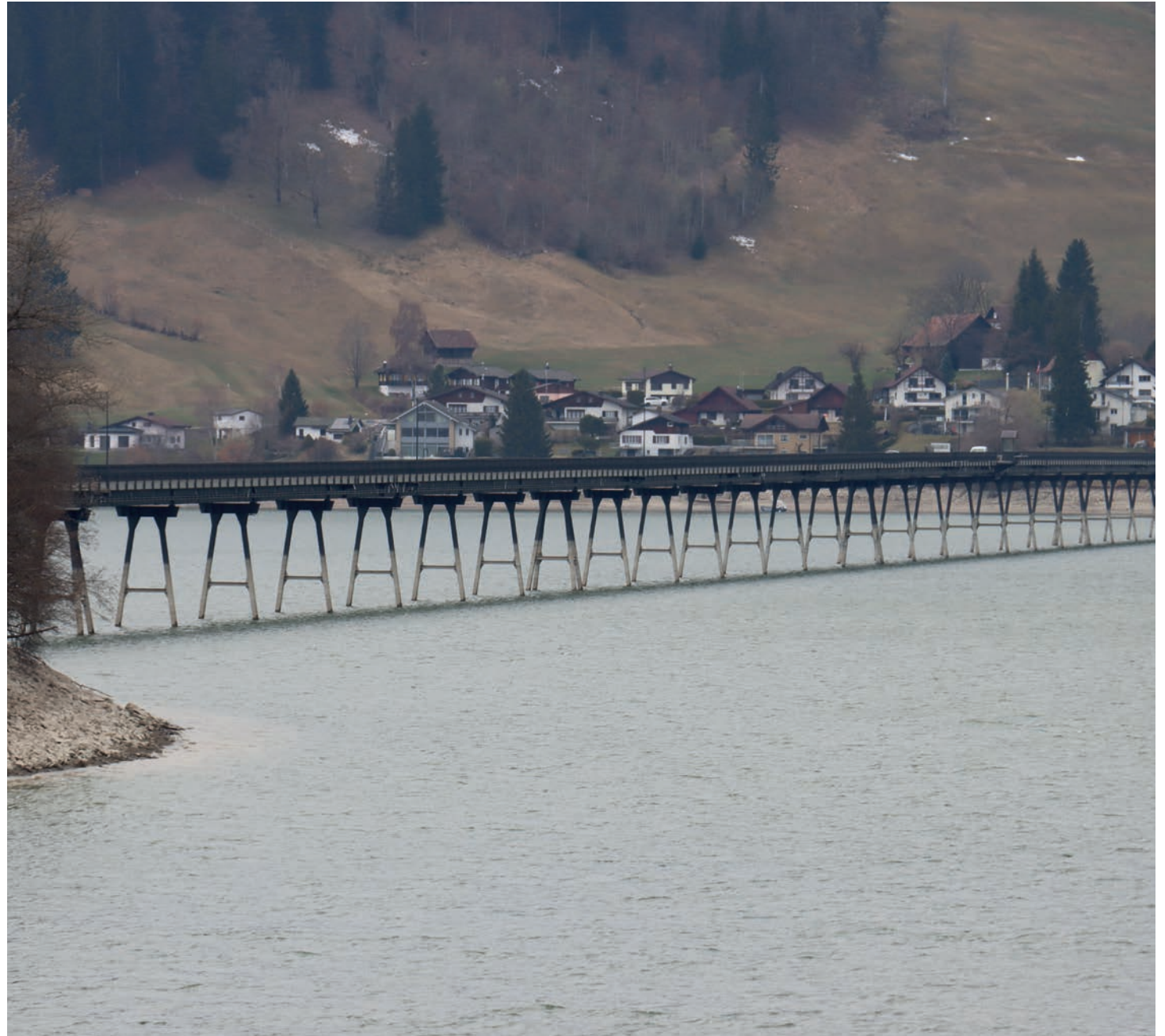
Der Willerzeller-Viadukt am 25. März 2026 – Pegelstand: 884.50 m ü. M.
